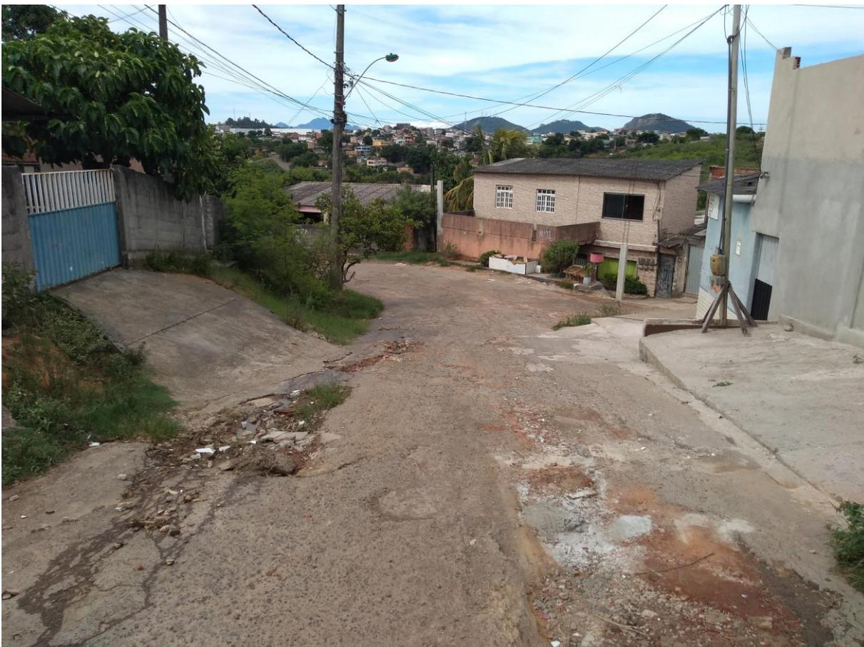
Figura 24 – Rua Tapajós, bairro Bela Vista. Percebe-se esgoto escorrendo à esquerda da foto, e pavimentação precária na rua. Fonte: acervo pessoal, 2019.
