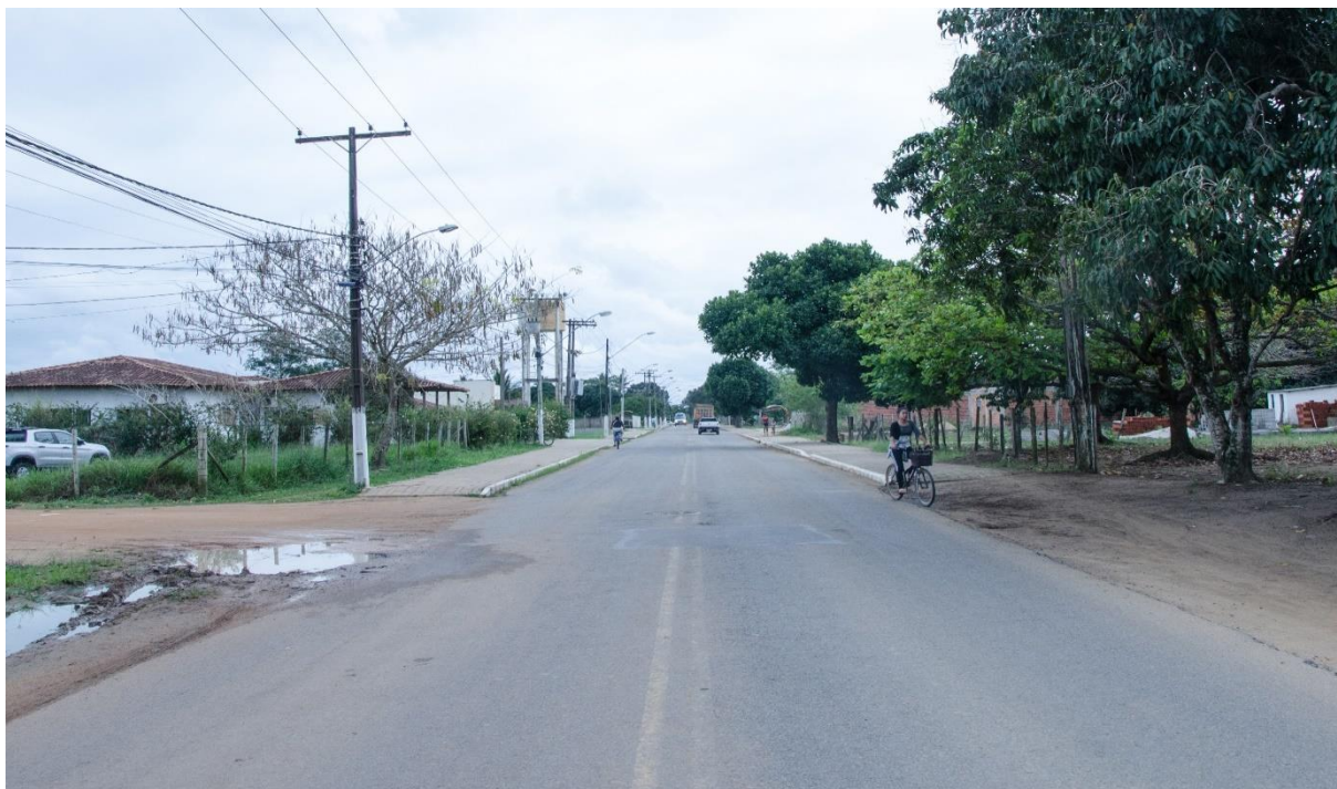
Figura 04 – Rodovia ES/456 que corta a aldeia de Caieiras Velha
