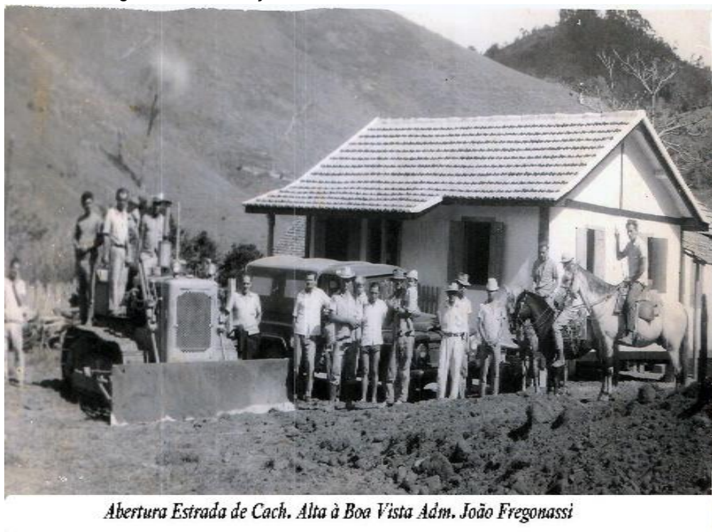
Figura 5 - Construção de estrada no interior de Alfredo Chaves
