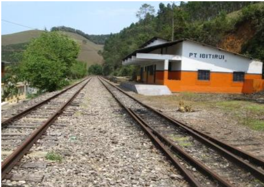
Figura 4 - Estação ferroviária Engano – Ibitiruí
