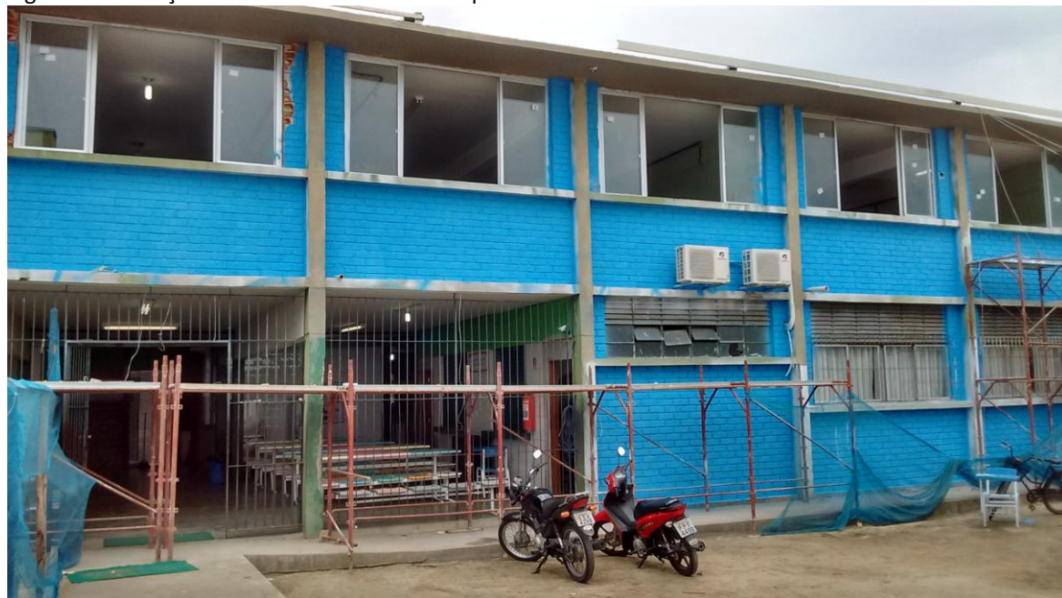
Figura 5 - Utilização de andaimes em frente ao portão de acesso à escola
