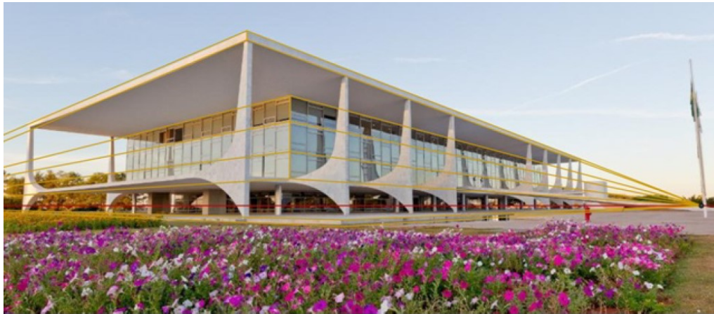
Figura 24: Palácio do Planalto em perspectiva cônica com dois pontos de fuga e as linhas de projeção.
