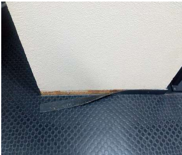
Fotografia 8 - Piso antiderrapante soltando
