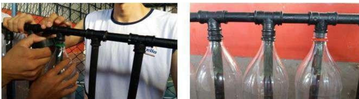
Figura 18 - Etapa de colocação das garrafas pet.
