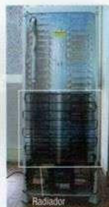
Figura 26: Foto de radiador de uma geladeira, também conhecido como condensador.
