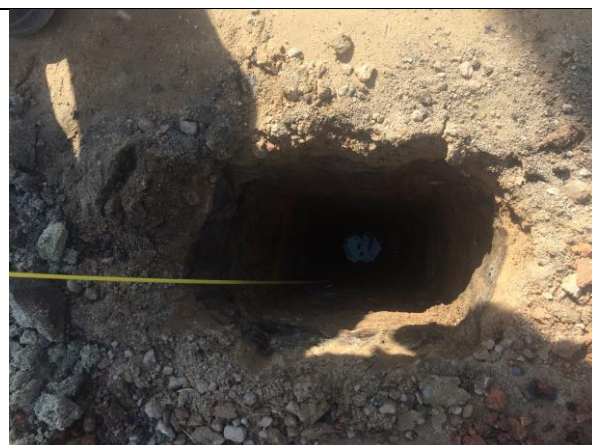
Figura 13: Medição das espessuras das camadas de solos na área estudada.
