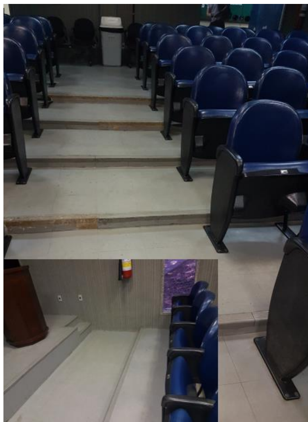
Figura 39 - Acesso de Auditório do CCS
