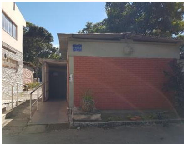
Figura 20 - Banheiro dos ED III e IV no CCJE
