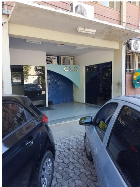
Figura 6 - Acesso ao prédio da Direção do CCS
