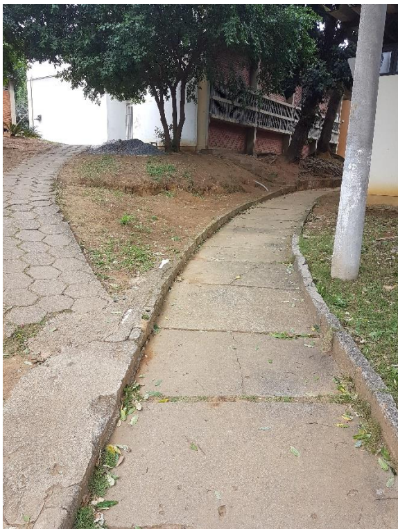
Figura 5 - Via de acesso no CCS
