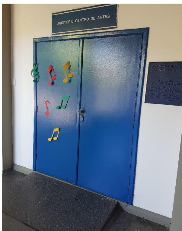
Figura 12 - Rampa no Auditório do CAR
