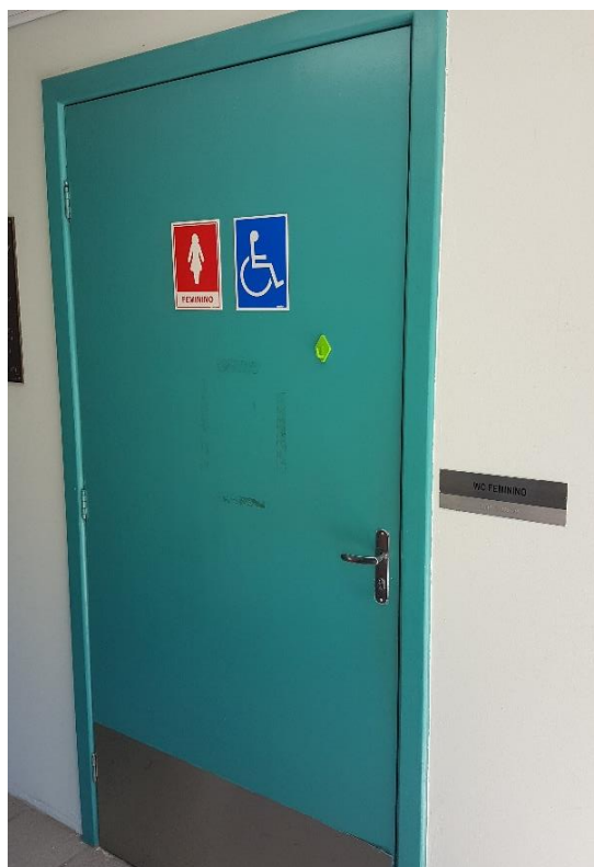
Figura 15 - Banheiro acessível na Administração do CE
