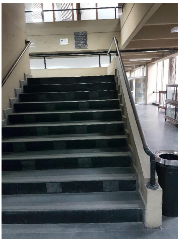
Figura 42 - Acesso aos pavimentos da Biblioteca Central
