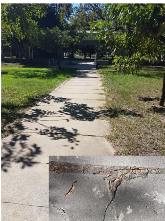
Figura 3 - Acesso ao CEMUNI IV
