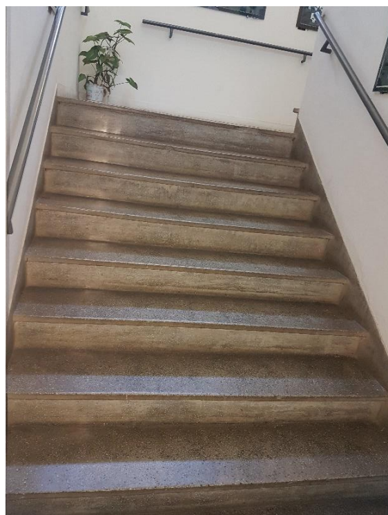
Figura 2 - Escadas na Administração do CCS
