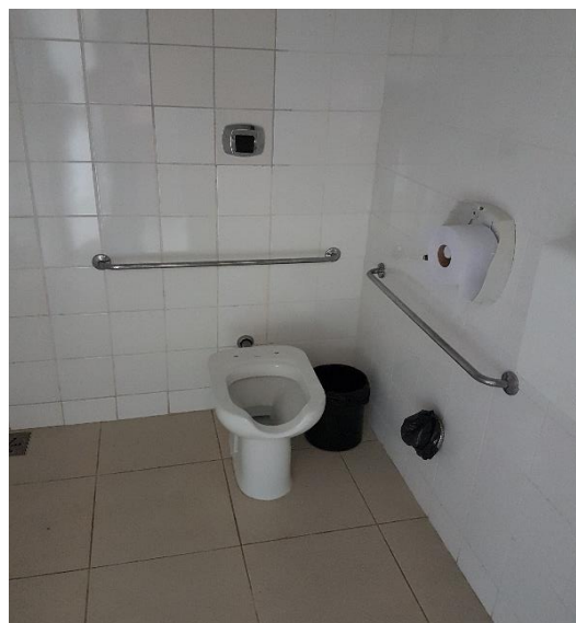
Figura 21 - Banheiro dos ED I e II
