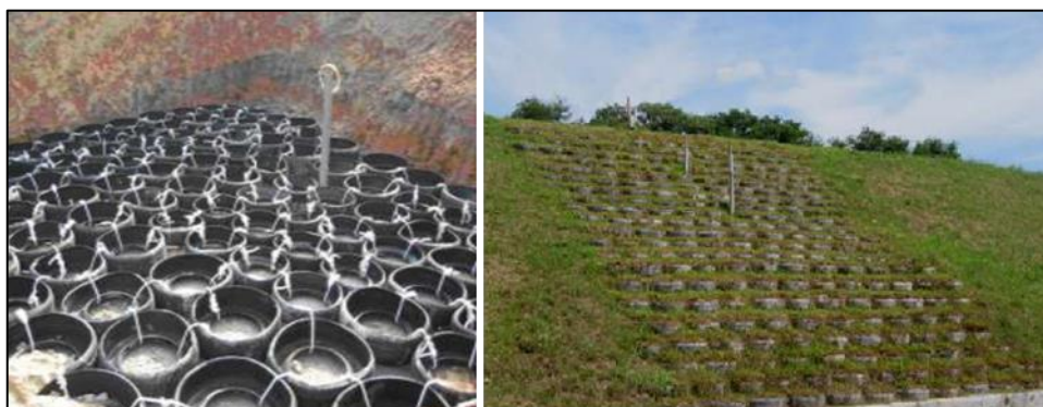
Figura 6: Amarração de pneus em camada inicial e muro concluído.
