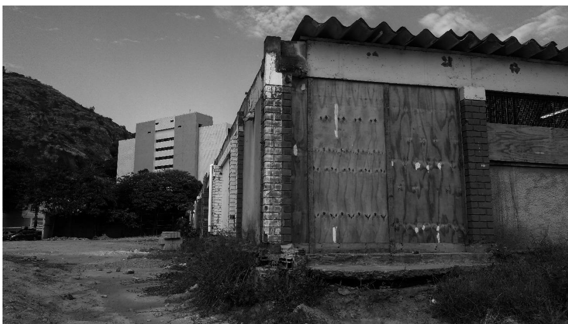
Imagem 11 – Fachada lateral da escola
