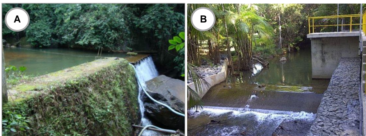
Figura 8 – Pontos de captação de água bruta (A - Rio Formate; B - Rio Santo Agostinho)
