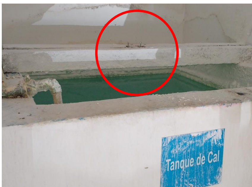
Figura 22 – Ausência de agitador mecânico reserva para o tanque de diluição de Cal
