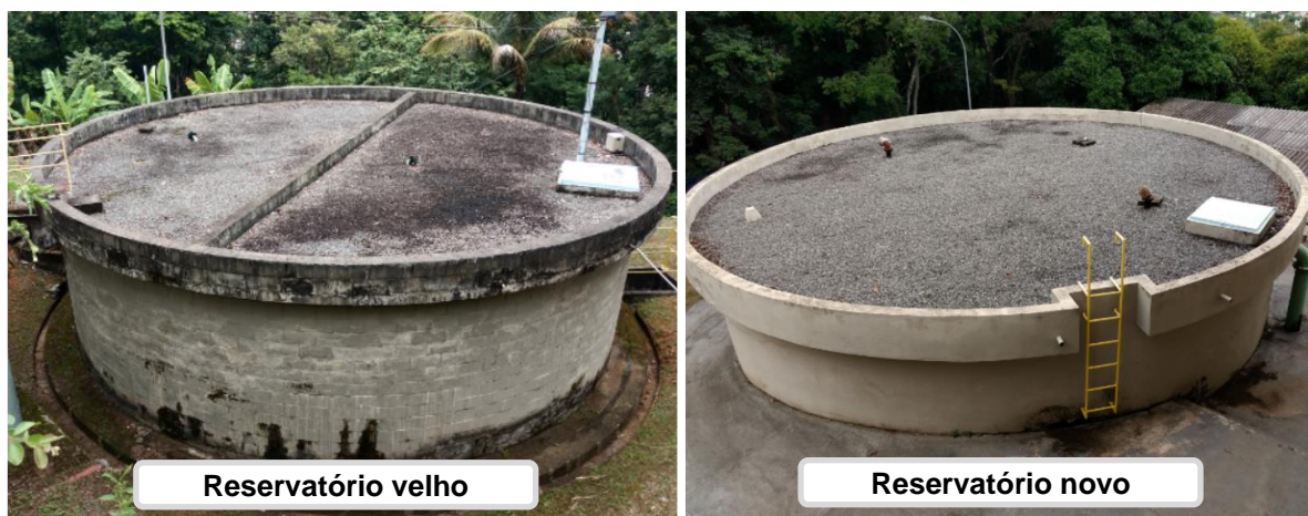
Figura 12 – Reservatórios da ETA Viana
