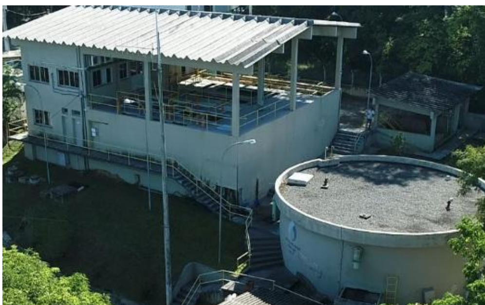
Figura 9 – Vista geral da ETA do município de Viana
