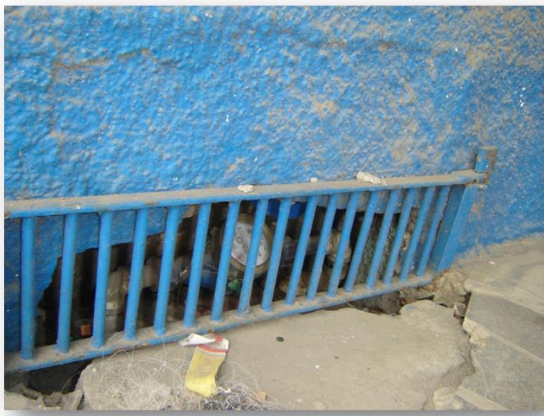
Figura 19 – Hidrômetro em posição inclinada
