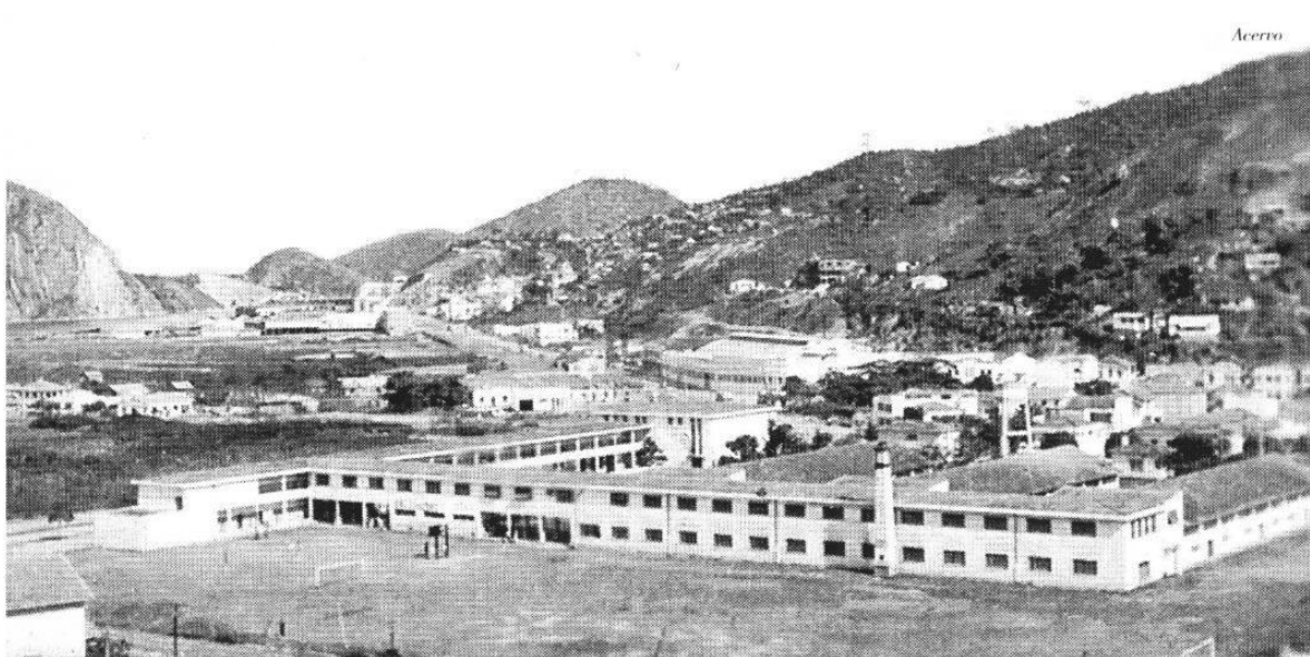
Figura 14: Prédio da Escola Técnica de Vitória.
