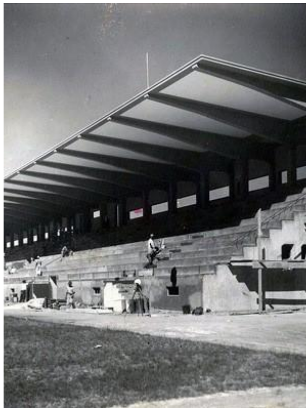
Figura 11: Estádio Governador Bley ainda em construção, 1938.
