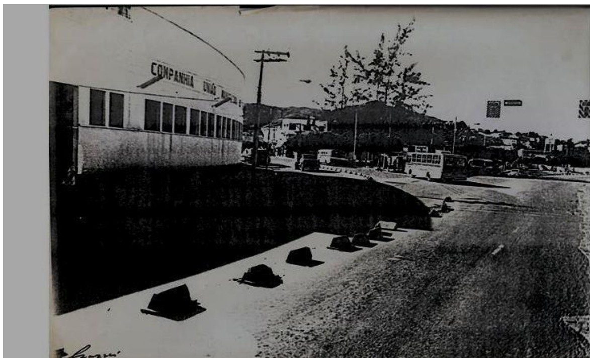
Figura 10: Registro da fábrica na década de 1970.
