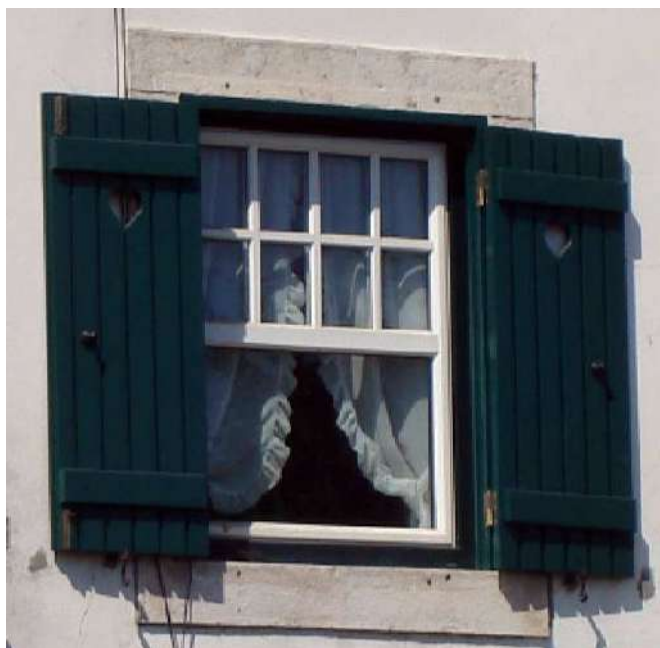
Figura 8: Janela com caixilharia dividida em quadrículas
