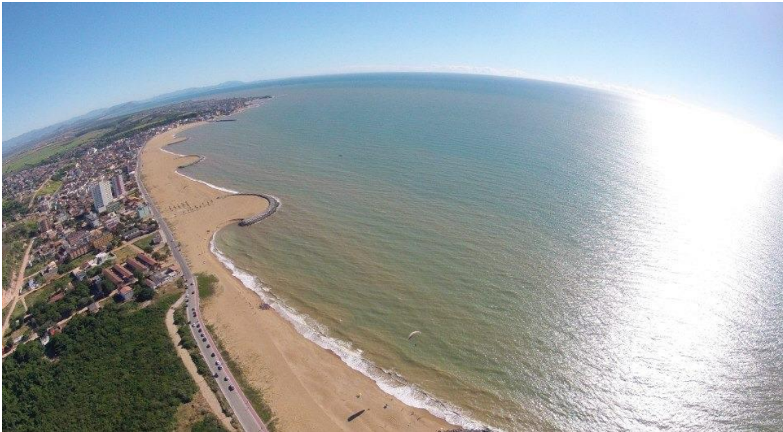
Figura 12 - Atual esquema de proteção costeira presente na Praia Central, Maratáizes - ES. Fonte: Prefeitura de Maratáizes.
