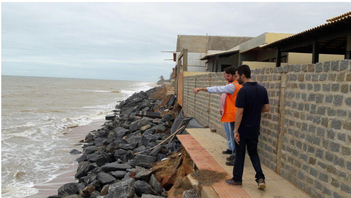
Figura 14 - Técnicos verificam as obras feitas em caráter emergencial, Marataízes - ES. Fonte: Prefeitura de Marataízes.
