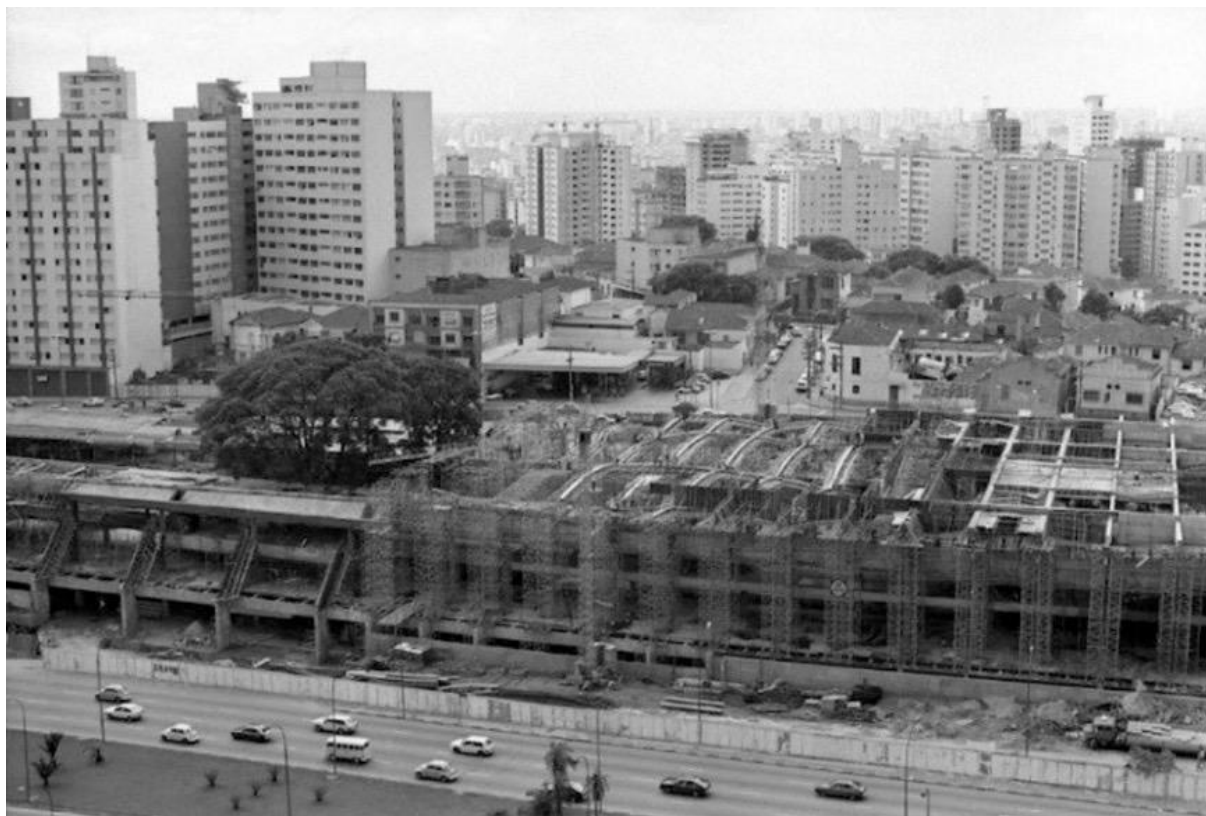
Figura 4 - CCSP durante de sua construção
