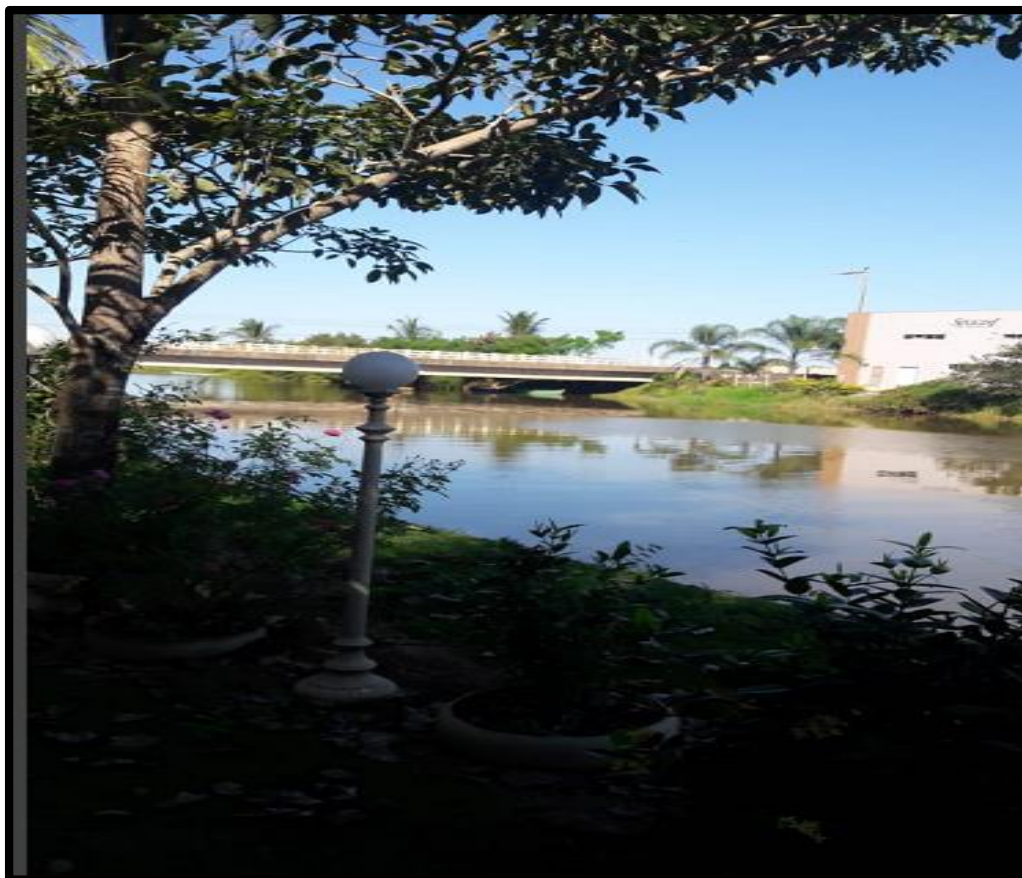
Imagem 24 – Vista da ponte e do canal de Itaputanga no local do piquenique literário
