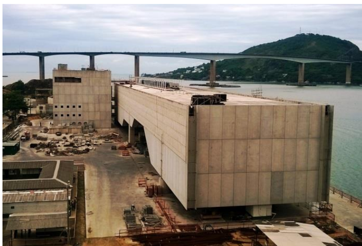
Figura 24. Vista de obras. Fonte: Acervo pessoal.
