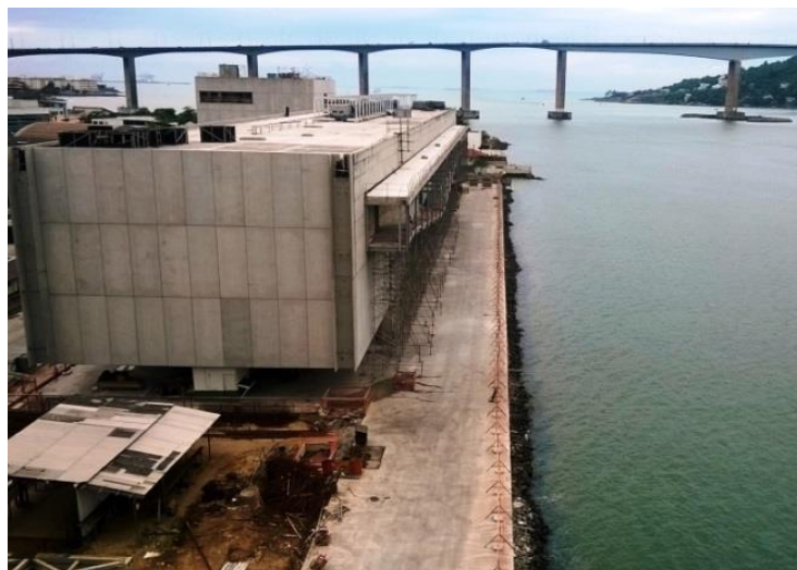
Figura 25. Vista de obras. Fonte: Acervo pessoal.
