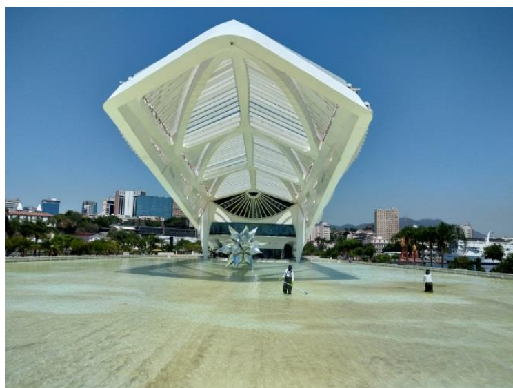
Figura 32. Vista da fachada traseira. Fonte: Acervo pessoal.
