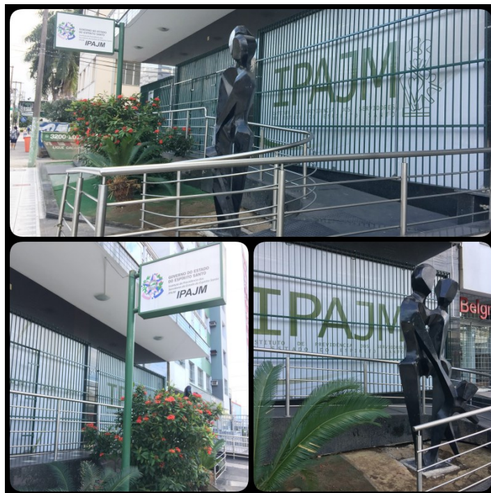
Figura 1 - Fachada do prédio sede do IPAJM à Avenida Cezar Hilal, 1.345, Santa Lúcia, Vitória/ES
