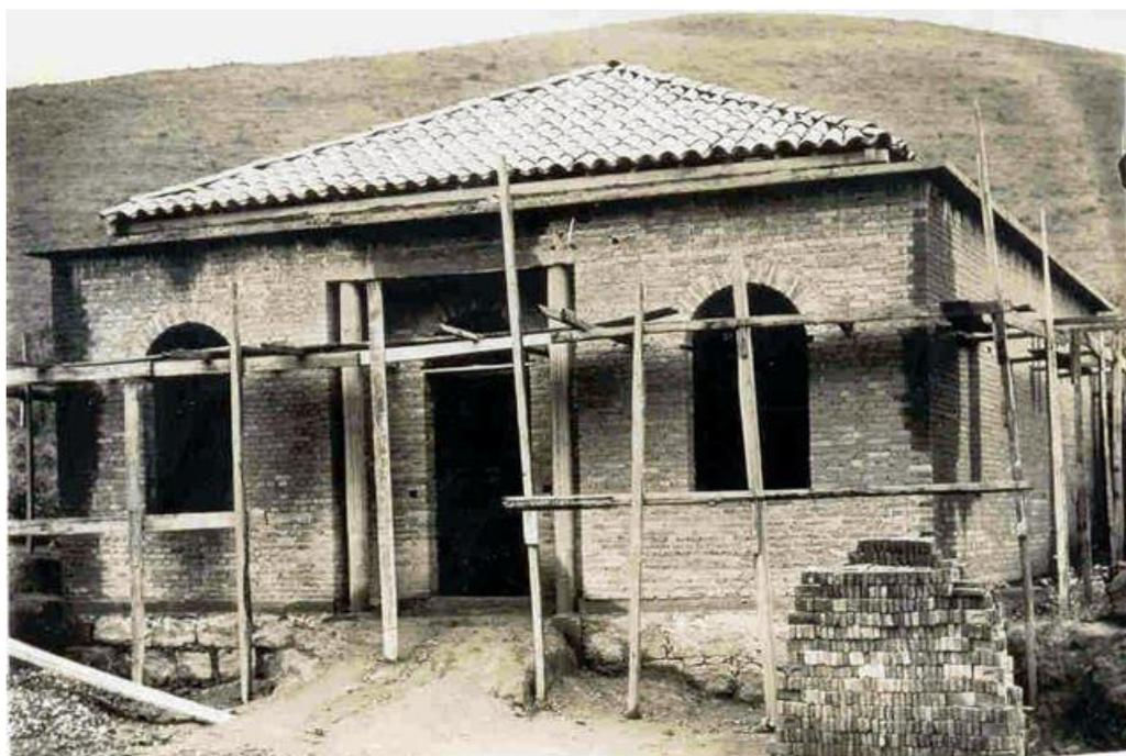
**Figura 28:** Construção de habitação em Guaçuí, com a fundação de pedras amarradas, e de paredes erguidas com tijolos adobes produzidos em formas. Fonte: Autor desconhecido. Acervo pessoal de Luiz F. Moulin.
