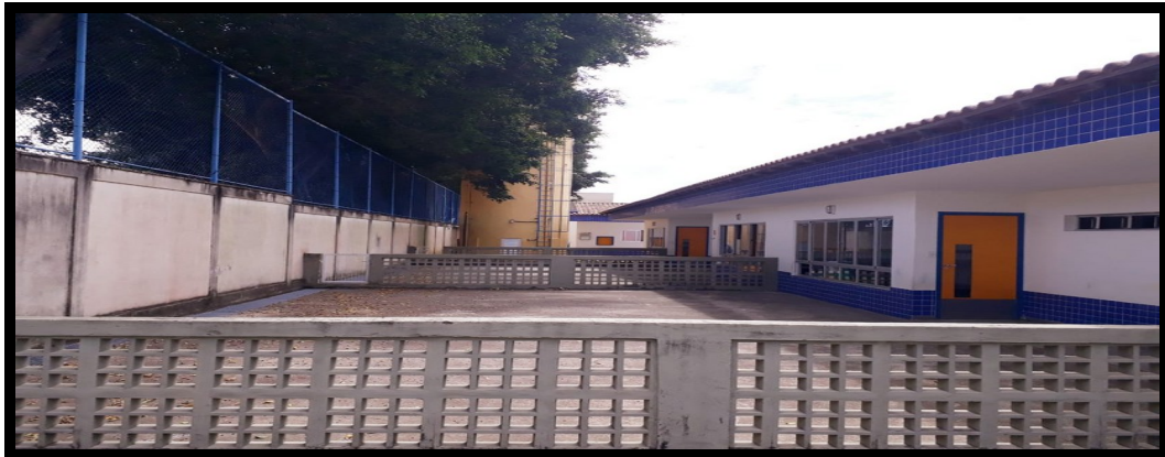
Foto 7 – Vista dos solários das salas dos Grupos II e III
