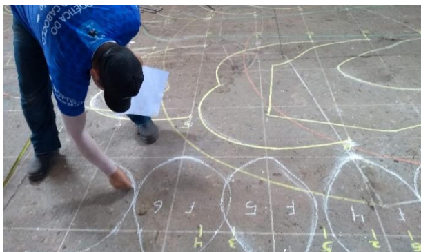
Fotografia 21 – Formas para contorno em ferro
