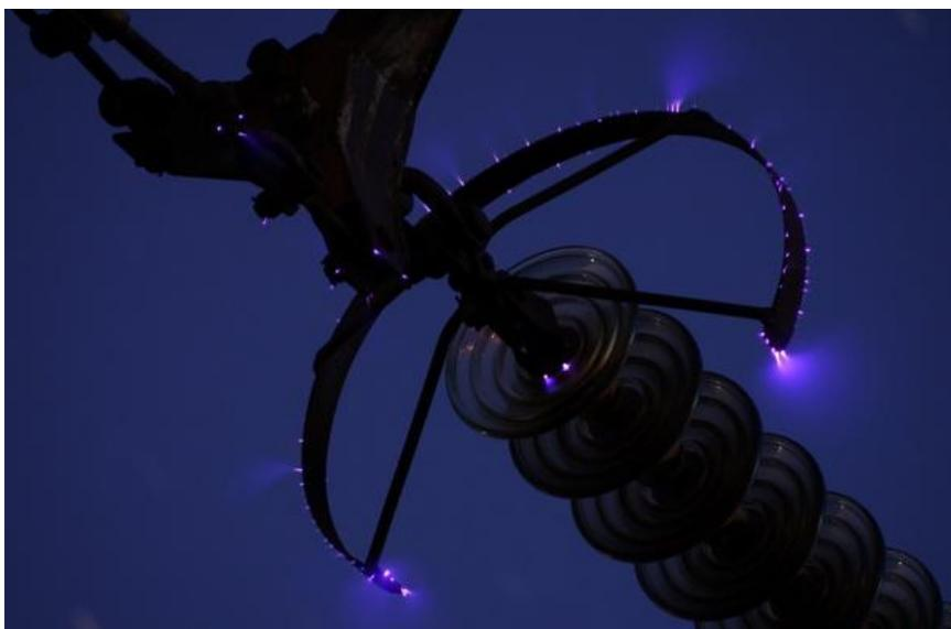
Figura 3 – Descarga corona em uma rede elétrica de alta tensão.
