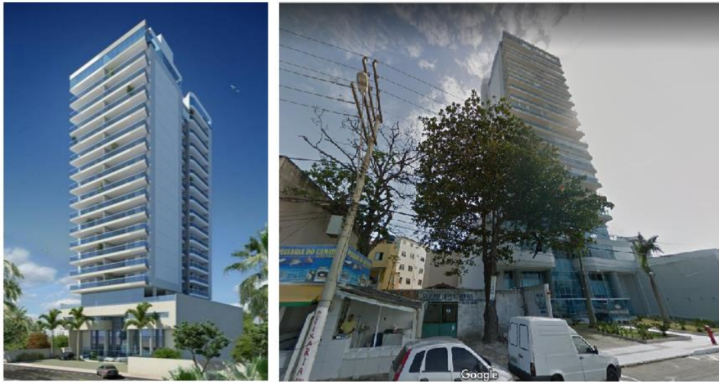
Figura 20: Projeção do Edifício Robson Setubal divulgada pela construtora e imagem do Google Street View.
