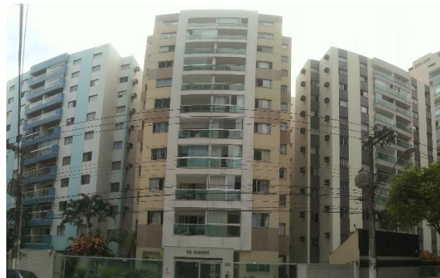
Figura 11: Edifícios Villena, Summer e Solar das Castanheiras. Acervo da autora.
