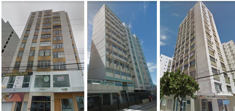
Figura 6: Edifícios Veleiros, Saveiro e Barravento. Fonte: Google Street View.
