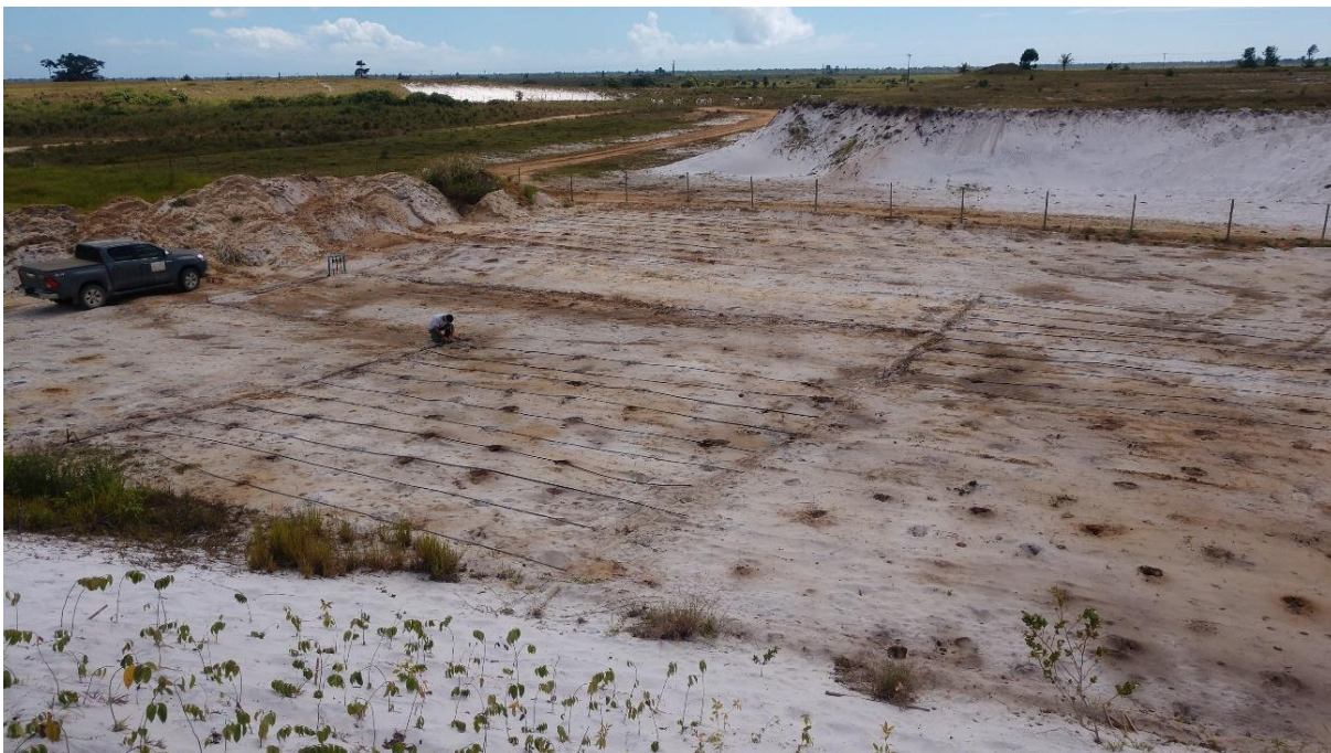
APÊNDICE 7. Instalação do sistema de irrigação.
