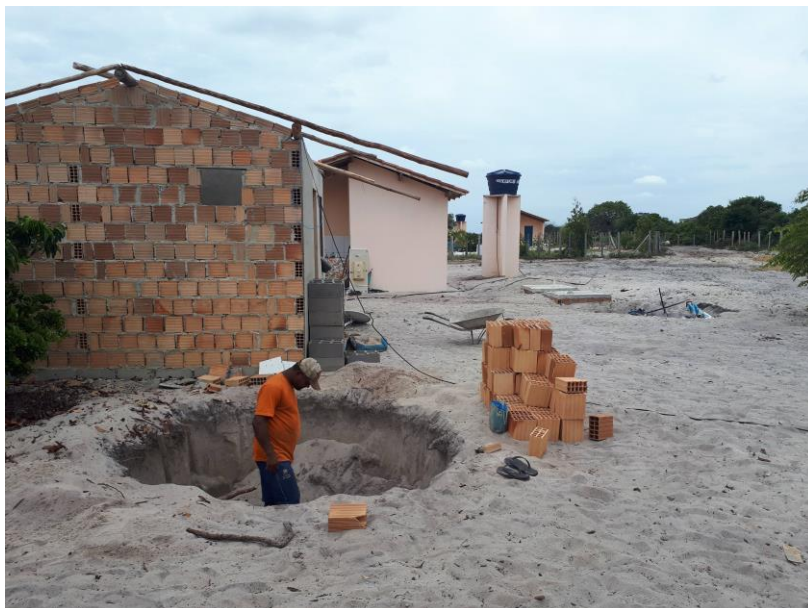
Fotografia 56 - Construção de fossa para suítes (hospedagem). Próximo à estrada na aldeia Xandó.
