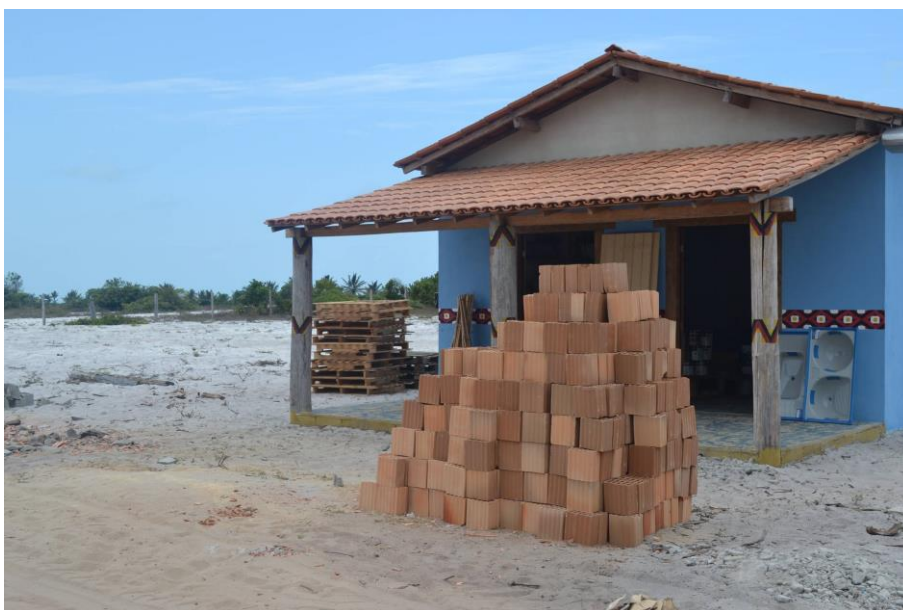
Fotografia 57 - Comércio de material de construção na aldeia Xandó
