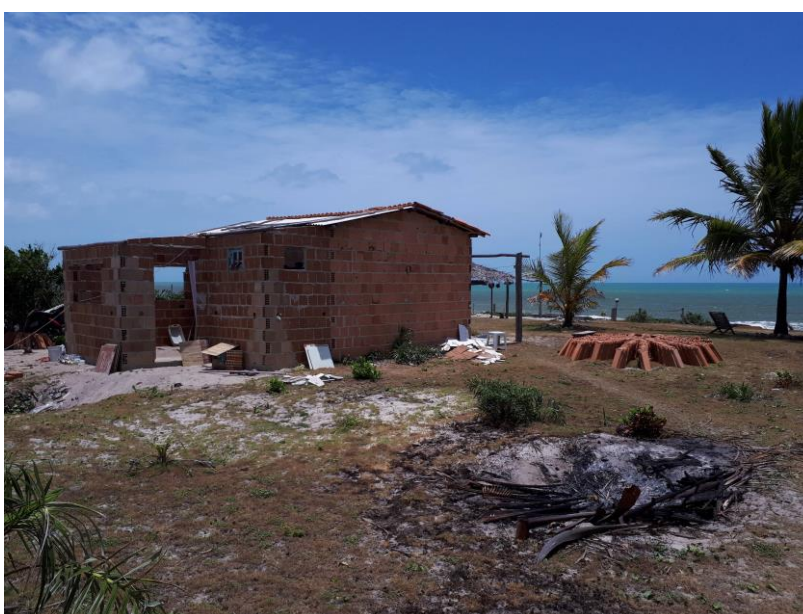
Fotografia 55 - Construção de casas e suítes para hospedagem de turistas à beira-mar na aldeia Xandó
