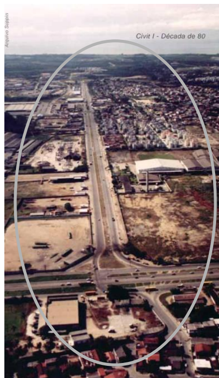
Figura 10- Construção do Civit I em 1980
