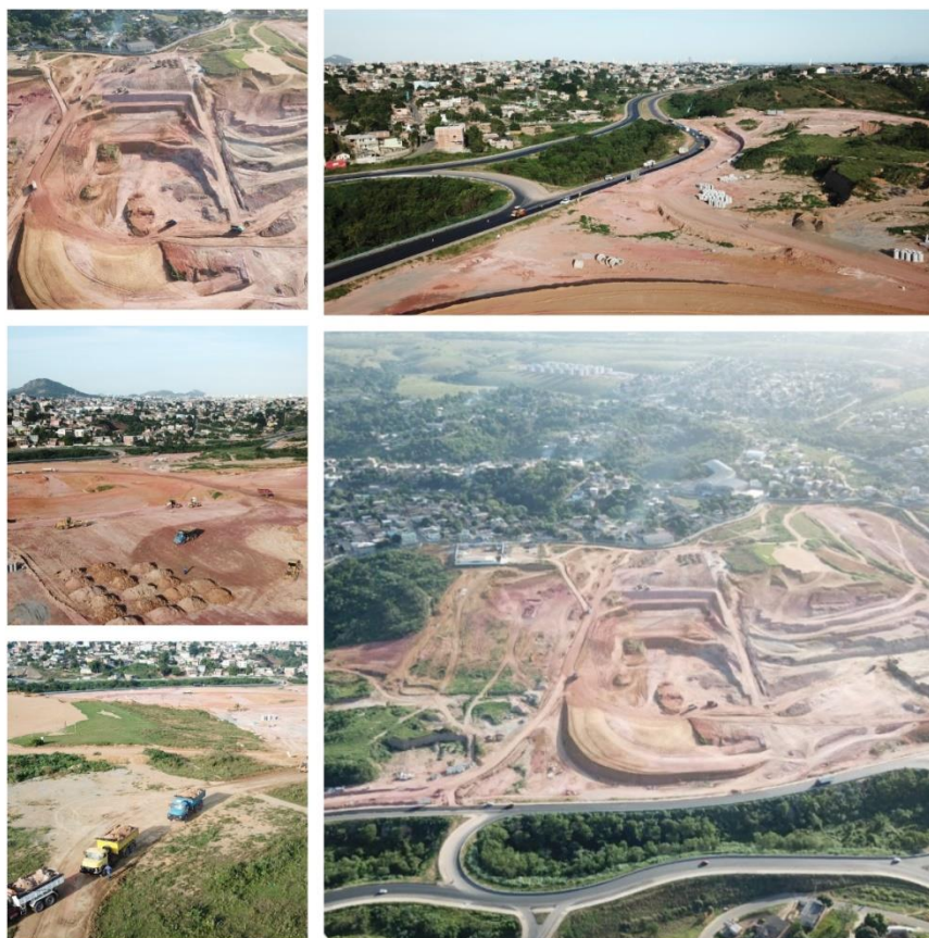
Figura 48- Condomínio Industrial Parque Leste-Oeste em construção- Cariacica-ES
