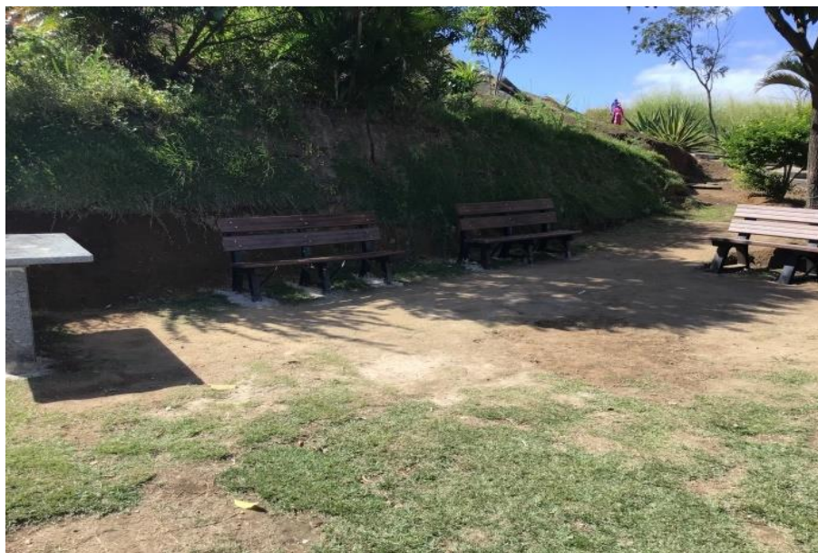
Figura 40: Muro das Lamentações, após obras de melhorias.
