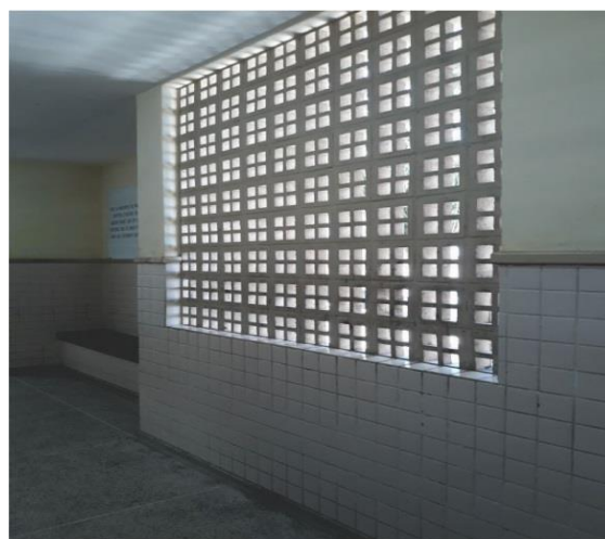
Fotografia 14 – Janela 1º andar
