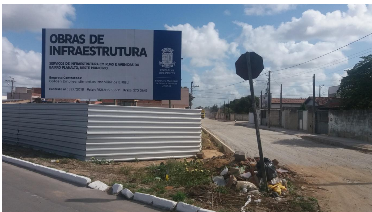
Figura 2 – Placa de comunicação das obras de infraestrutura no bairro Planalto, 2019
