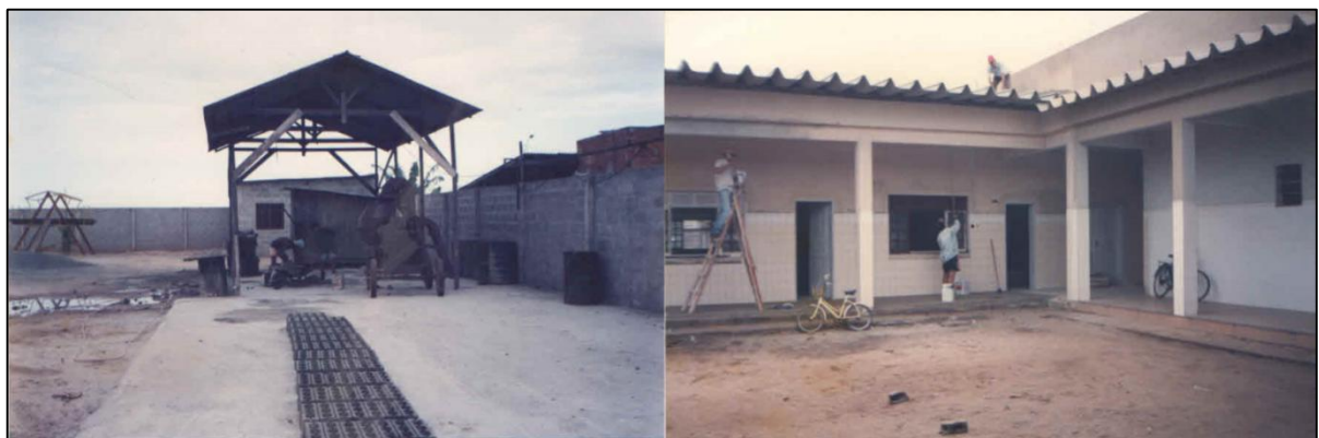
Figura 3 – Construção da AAOCA
