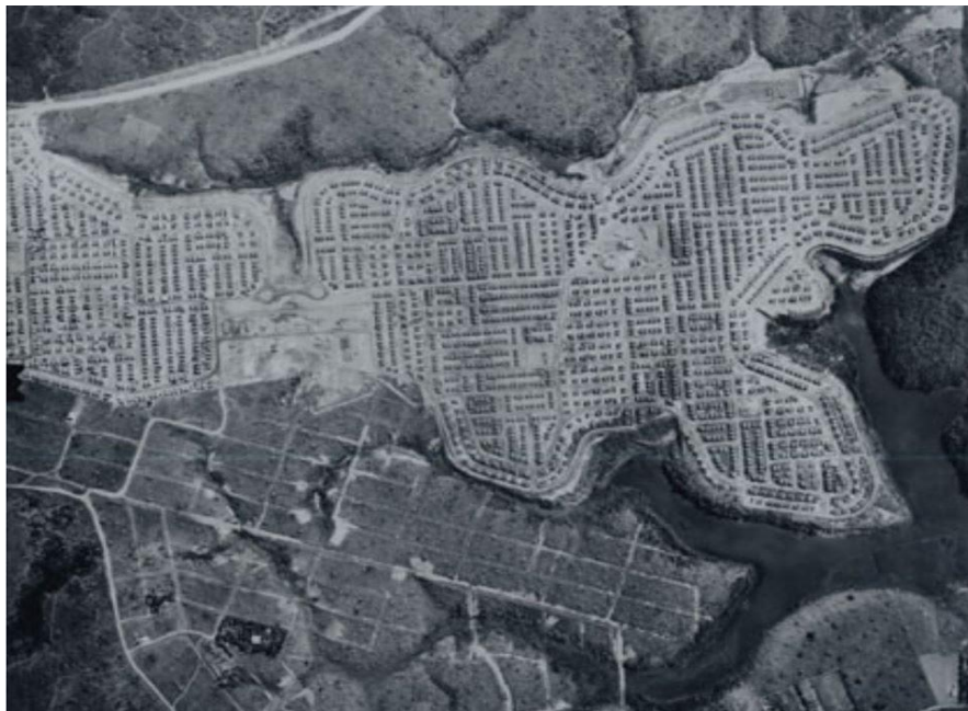
FIGURA 06: Fotografia aérea do Conjunto Pedro Feu Rosa.
