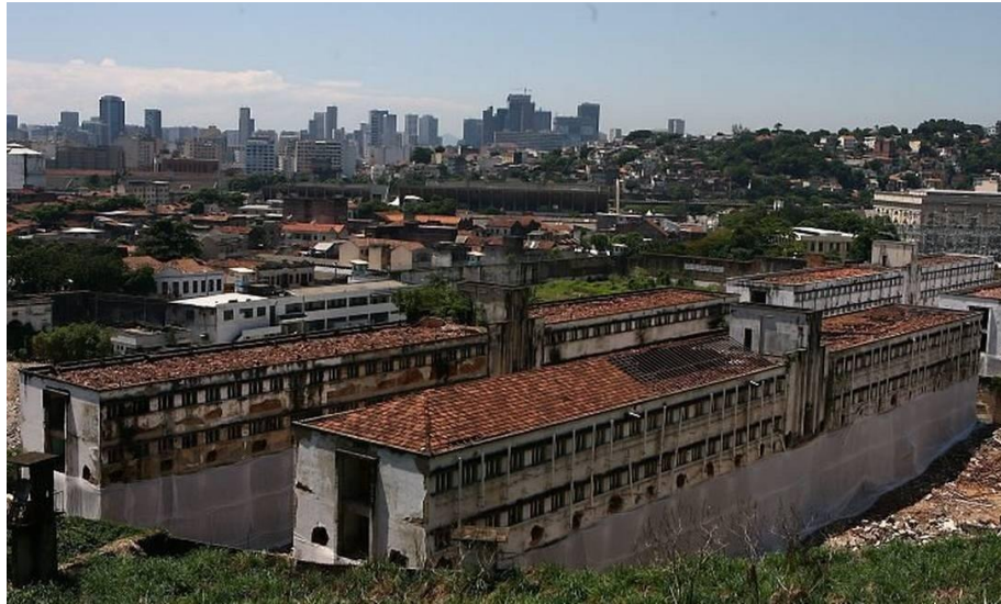
Figura 3 – Casa de Correção da Corte em 2010, antes de sua demolição
