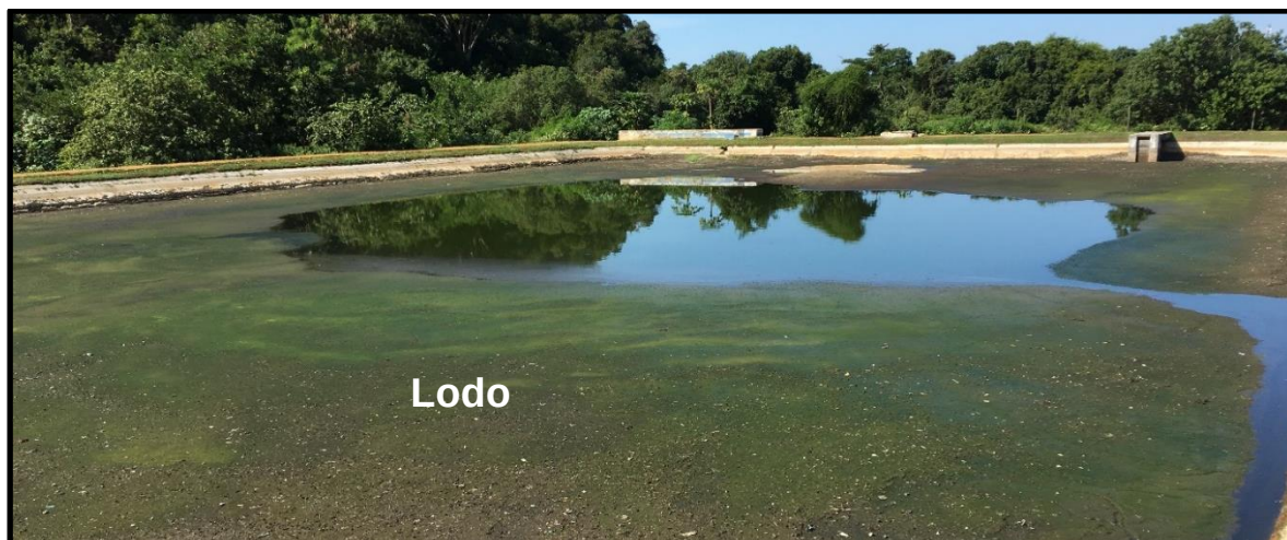
Figura 83 - ETE Piúma – Lagoa Anaeróbia, 2019.
