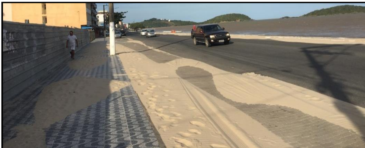
Figura 95 - Presença de areia de praia nas vias de tráfego devido à ação eólica e litoral desprovido de vegetação para fixar a areia do sistema praial – Piúma, 2017.
