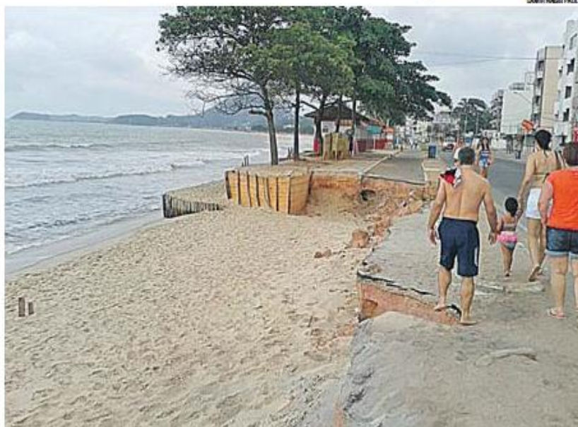
TRECHO do calçadão da praia de Piúma, que foi destruído pelas ondas levando risco para os pedestres
