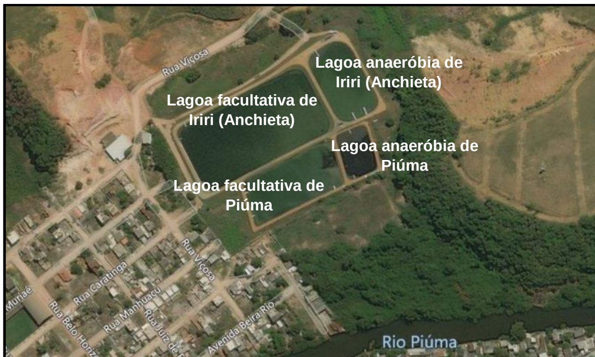
Figura 79 - Imagem aérea da ETE de Piúma, 2020.
