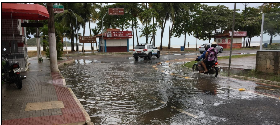
Figura 30 - Avenida Beira Mar - ausência de drenagem pluvial (b), 2019.
