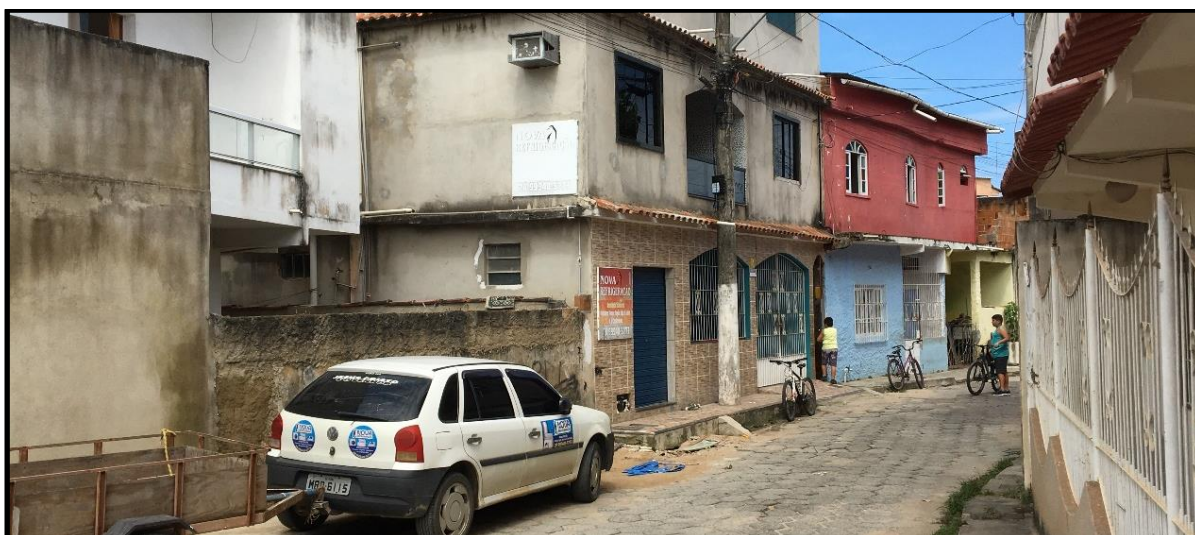
Figura 24 - Tipologia das edificações em Piúma (a), 2019.
