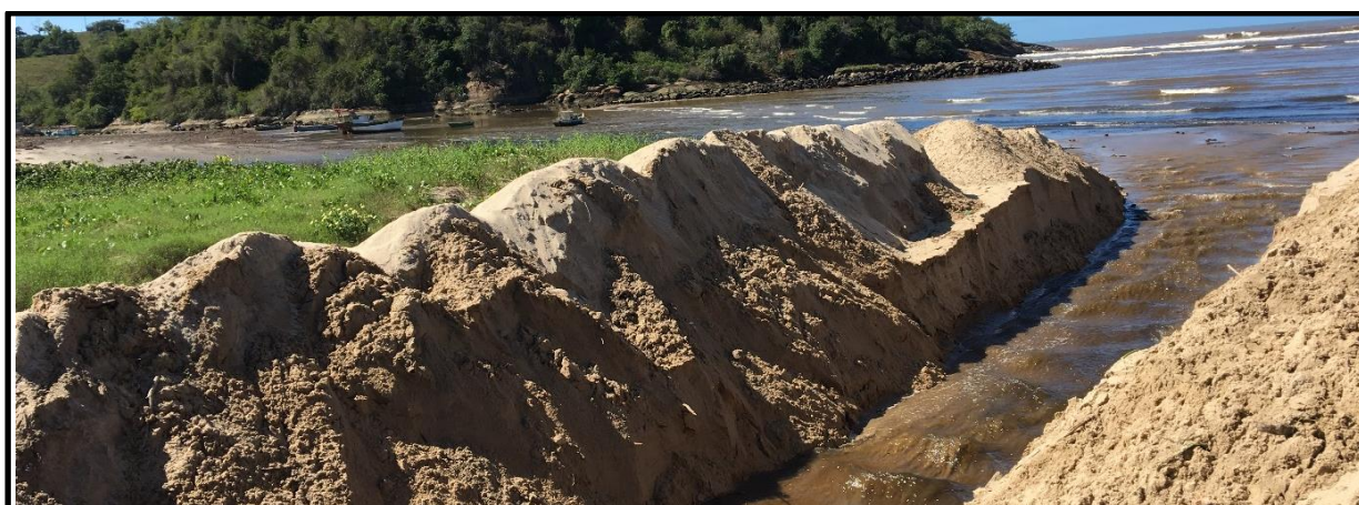
Figura 93 - Retirada do acúmulo de água pluvial e de esgoto doméstico na área dos fundos do IFES Campus – Piúma pela PMP (c), 2019.
