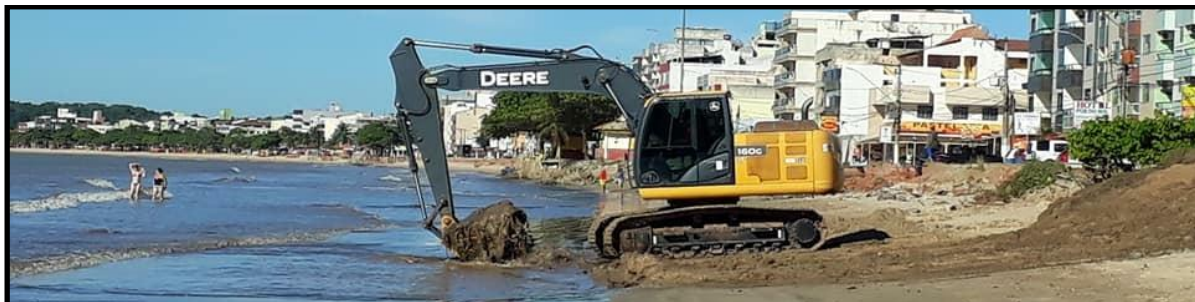
Figura 103 - Obra paliativa para contenção da erosão da orla – Praia de Acaiaca, 2018.
