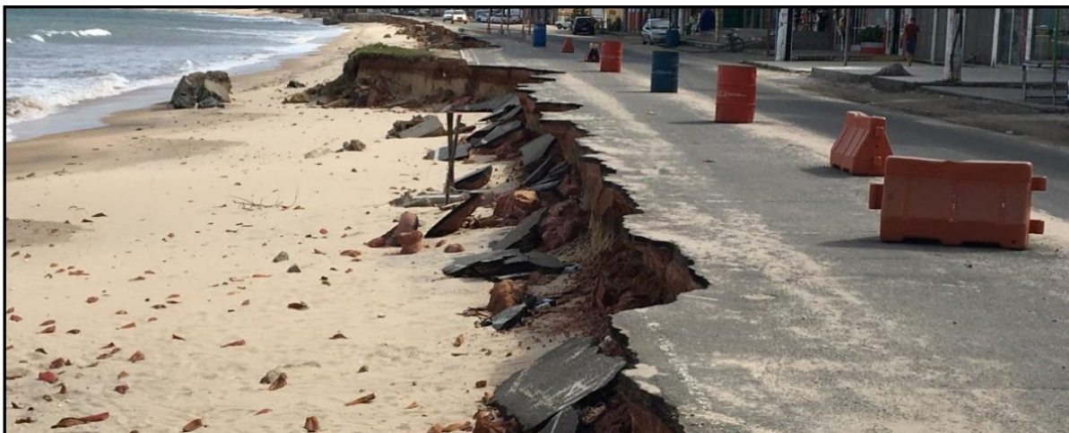
Figura 97 - Agravamento da erosão da orla, sentido Centro de Piúma – Itapemirim, 2018.
