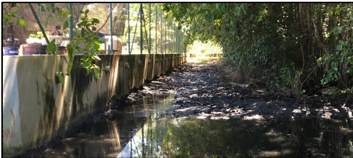
Figura 89 - Acúmulo de água pluvial e de esgoto doméstico na área dos fundos do IFES Campus – Piúma (a), 2019.
