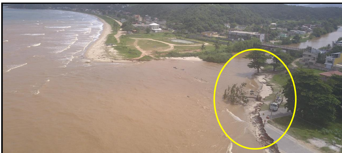
Figura 123 - Novo ponto de erosão em Piúma, 2020.
