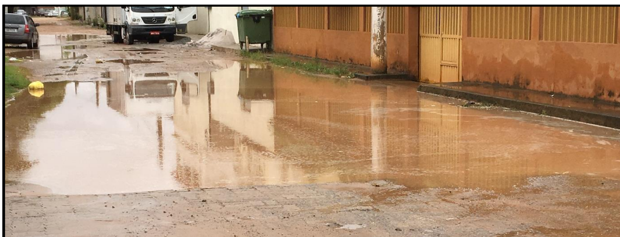
Figura 8 - Rua sem pavimentação e com grande acúmulo de água (b), 2019.
