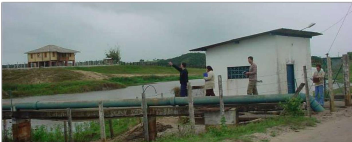
Figura 77 - ETA de Piúma.
