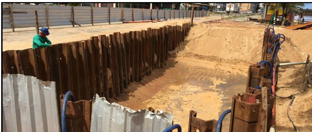
Figura 118 - Construção do muro de contenção, 2020 (b).
