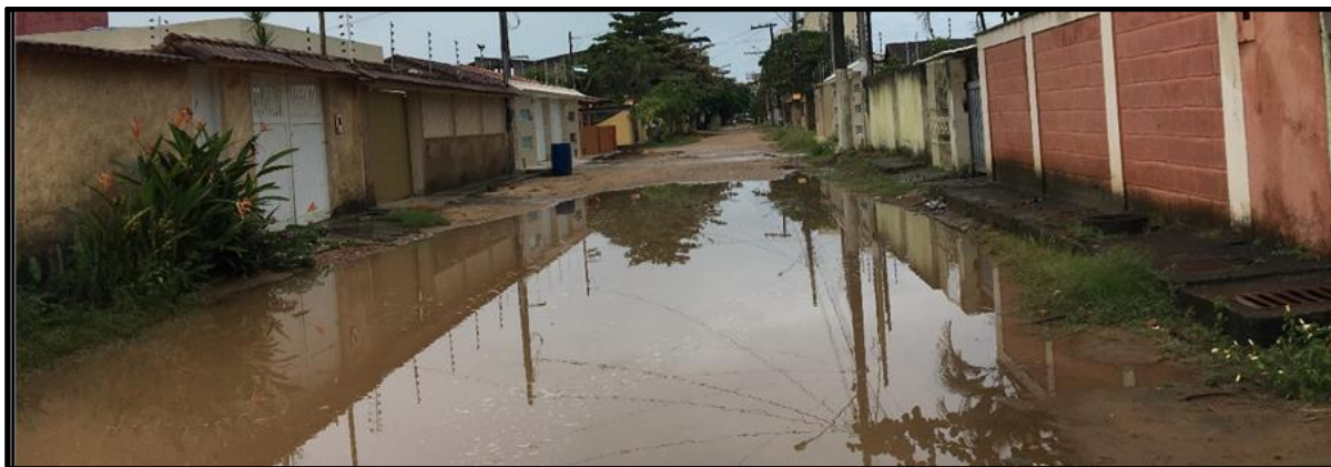
Figura 7 - Rua sem pavimentação e com grande acúmulo de água (a), 2019.
