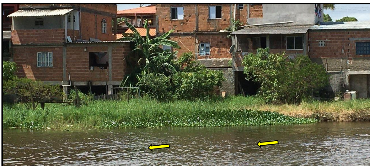
Figura 50 - Casas situadas à margem direita do Canal de Itaputanga, 2019.
