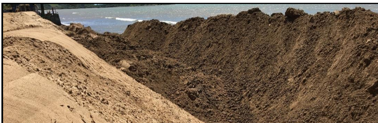
Figura 104 - Obra paliativa para contenção da erosão da orla – Praia de Jardim Maily (a), 2018.
