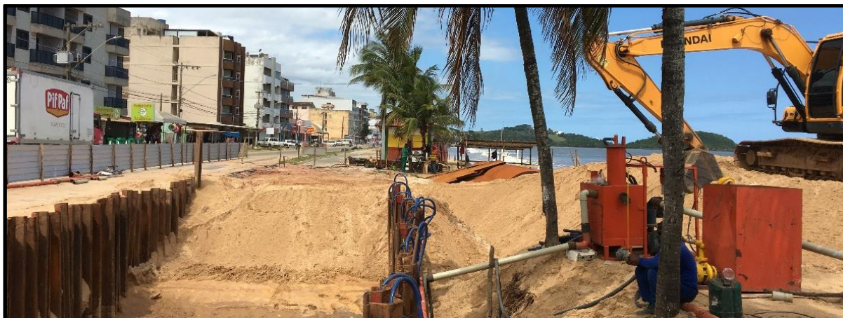
Figura 117 - Construção do muro de contenção, 2020 (a).
