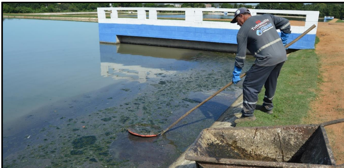
Figura 87 - Retirada manual do lodo na Lagoa Anaeróbia de Piúma, 2019.
