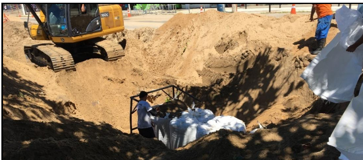
Figura 105 - Obra paliativa para contenção da erosão da orla – Praia de Jardim Maily (b), 2018.
