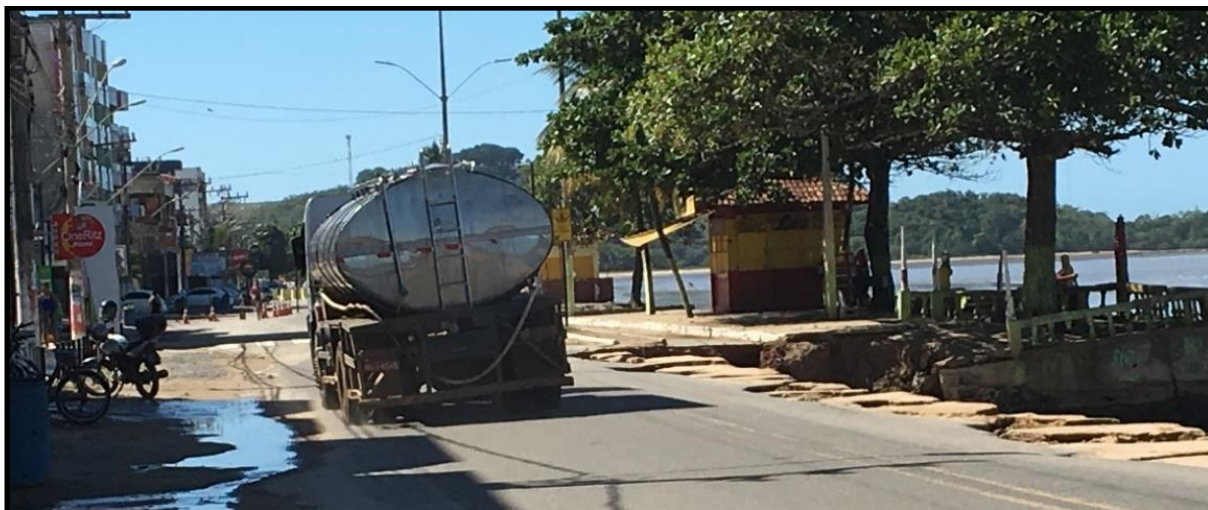
Figura 111 - Destruição da obra paliativa - Praia de Jardim Maily (d), 2019.
