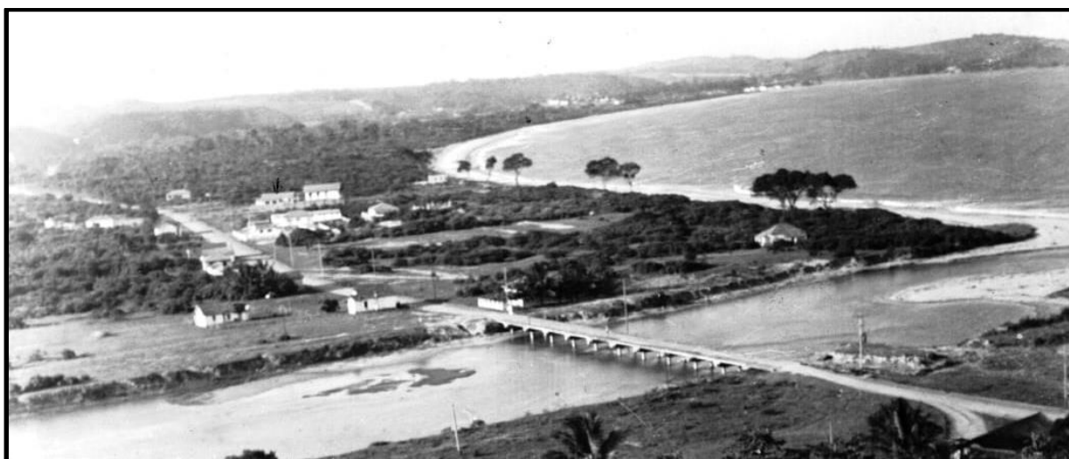
Figura 40 - Ponte sobre o Canal de Itaputanga, Piúma - 1971.
