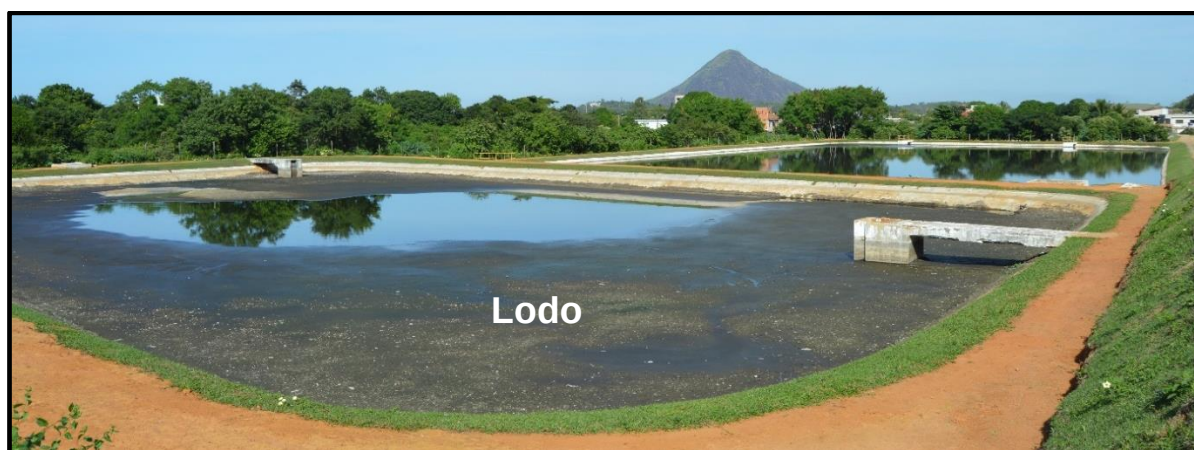
Figura 82 - ETE Piúma – Lagoa Anaeróbia de Piúma, 2019.
