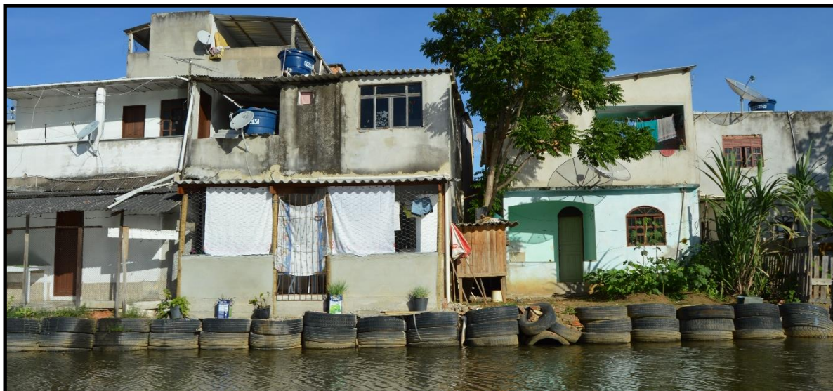
Figura 31 - Residências construídas às margens do rio Piúma (a), 2019.
