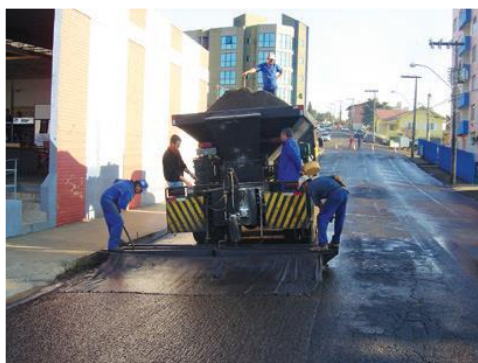
Figura 3 - Aplicação da lama asfáltica
