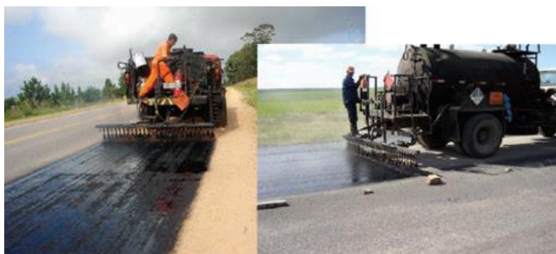
Figura 4 - Aplicação de pintura de ligação
