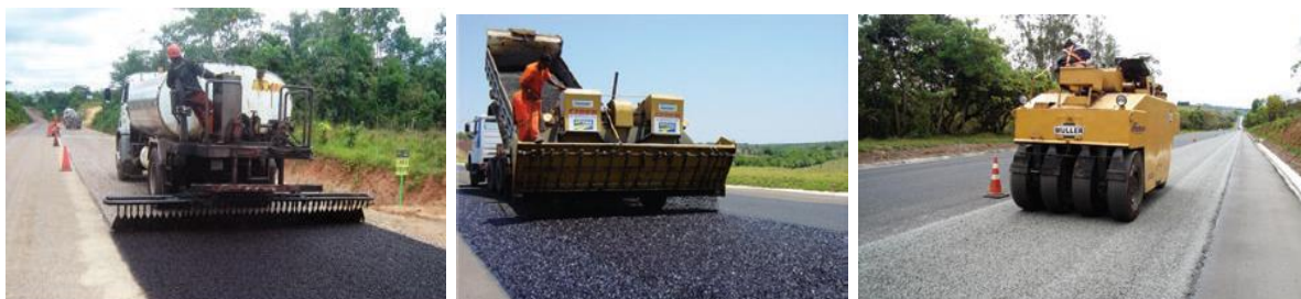
Figura 2 - Aplicação do ligante, aplicação dos agregados e compactação
