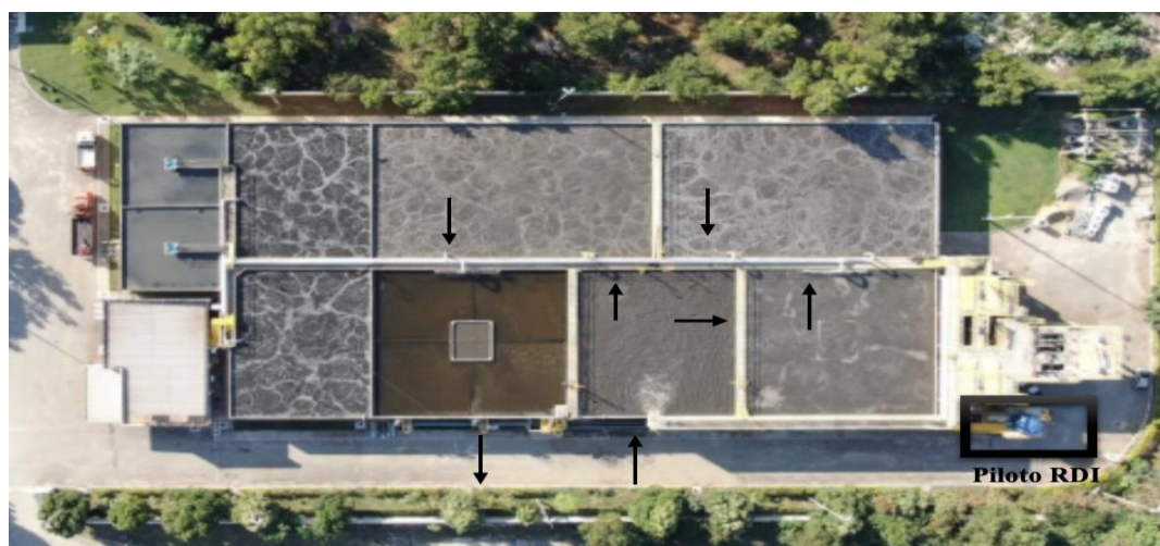
Figura 6 - Sistema de Tratamento ETE Araçás
