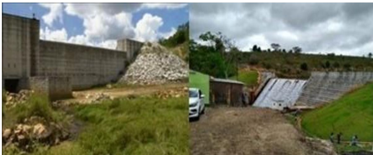
Figura 15- a) Espaçamento de vertedouro da Barragem Eng. Valter. José. Matielo, ainda com comporta aberta; b) ao lado do carro é possível identificar o espaçamento de vertedouro mantendo o fluxo necessário do rio.
