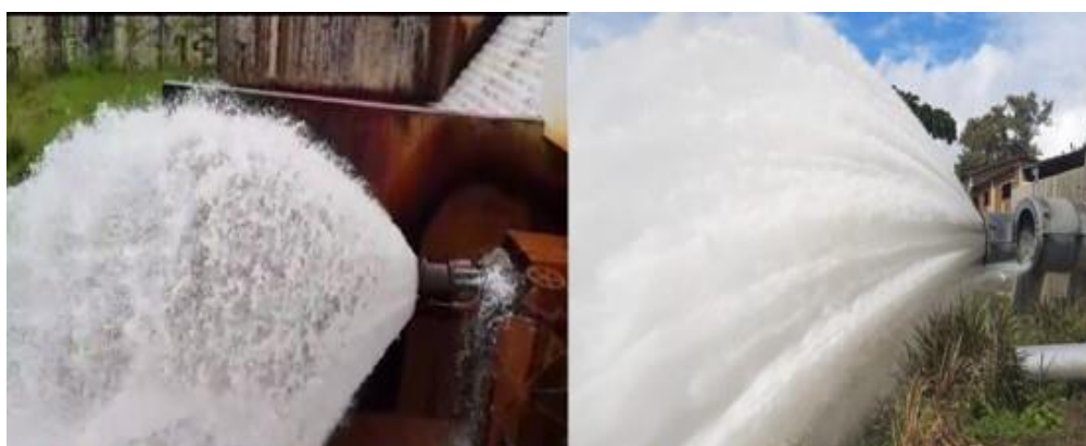
Figura 19 - Comporta aberta da barragem “Eng. Valter José Matielo” e b) ANA determina abertura de comporta do Açude de Boqueirão para atender Barragem de Acauã e ribeirinhos.
