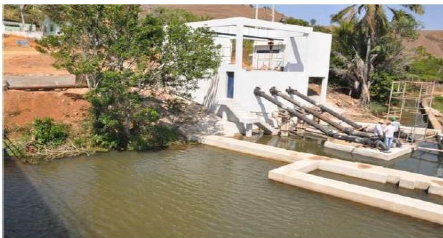
Figura 20 - Captação Rio do Norte (obras).
