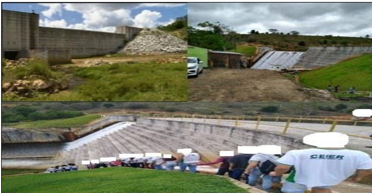
Figura 54 - a) Espaçamento de vertedouro da Barragem Eng. Valter. José. Matielo, ainda com comporta aberta; b) ao lado do carro é possível identificar o espaçamento de vertedouro mantendo o fluxo necessário do rio e c) momento da descida a casa de controle da comporta da barragem pelos alunos.
