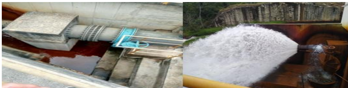
Figura 13-Duto do vertedouro ligado a comporta, da barragem visitada e b) comporta aberta.
