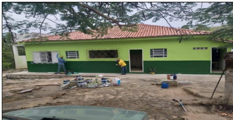
Figura 22 - Reforma no gabinete da concessionária, ao lado da barragem.
