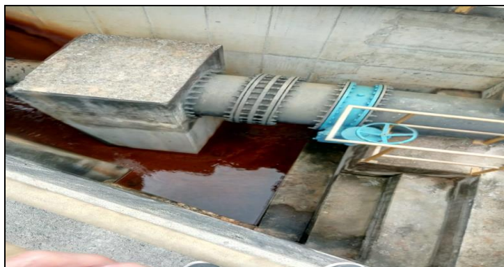
Figura 14- Duto do vertedouro ligado a comporta, da barragem visitada.
