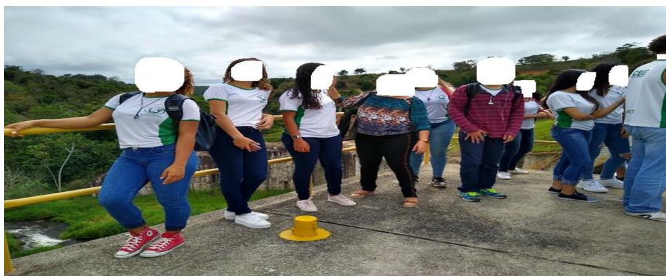
Figura 9 - É possível identificar um dos piezômetros (cor amarela) da barragem de visita, no chão.
