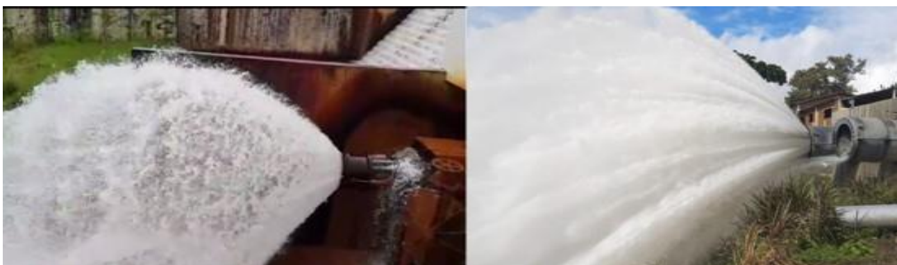
Figura 57 - Comporta aberta da barragem “Eng. Valter José Matielo” e b) ANA 45 determina abertura de comporta do Açude de Boqueirão para atender Barragem de Acauã e ribeirinhos.
