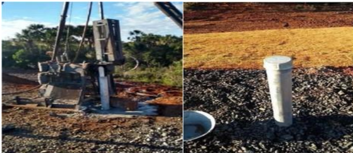
Figura 45 - (a) Encaixe do tubo e (b) Instalação finalizada
