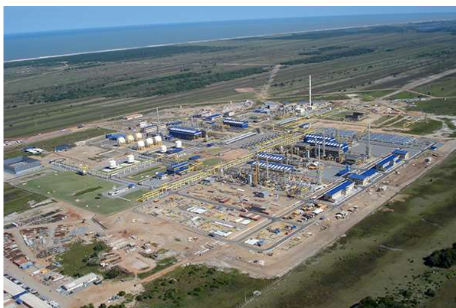
Figura 51: Unidade de Tratamento de Gás de Cacimbas - UTGC (Linhares-ES)
