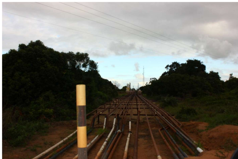
Figura 49: Rede de gasodutos comunicando com a UPGN – Lagoa Parda (Linhares-ES)
