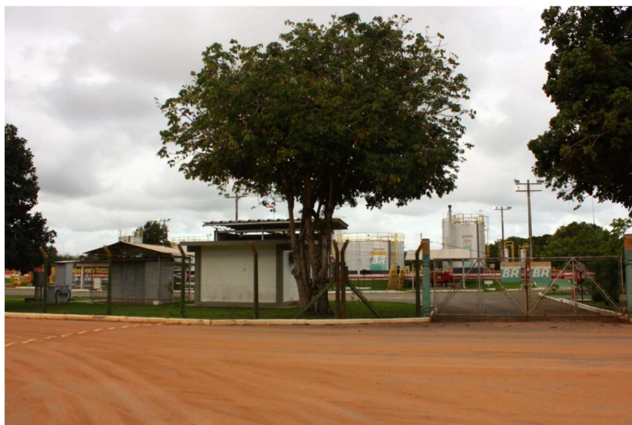
Figura 50: Unidade de Processamento de Gás Natural (UPGN) – Lagoa Parda (Linhares-ES)
