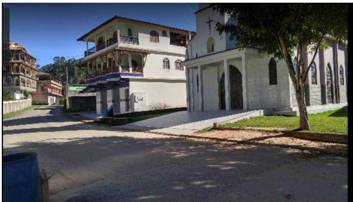
Fotografia 3: Rua principal de São Bento de Urânia, com vista da igreja católica
