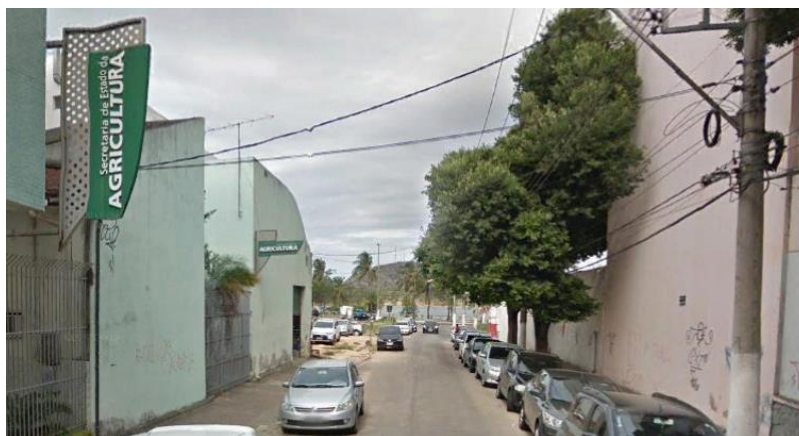
Figura 10 – Vista da Fachada do Prédio Anexo SEAG (lado esquerdo), ao fundo Garagem com acesso independente
