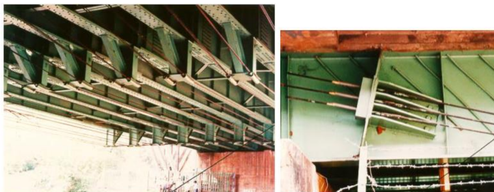
Figura 4 - Ponte Condet reforçada com protensão externa e detalhe da ancoragem da protensão
