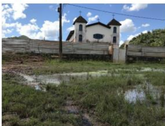
Entorno da Igreja alagada impedindo o uso do acesso principal e causando danos ao bem tombado. Foto: Flora Passos/Cáritas-MG, em 09/03/22.
