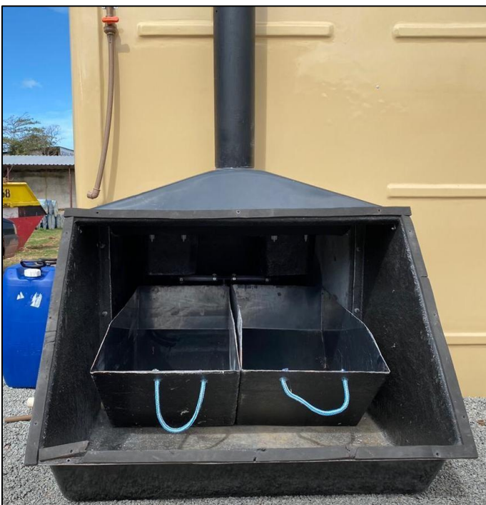
Figura 19: Caixas de armazenamento das fezes
