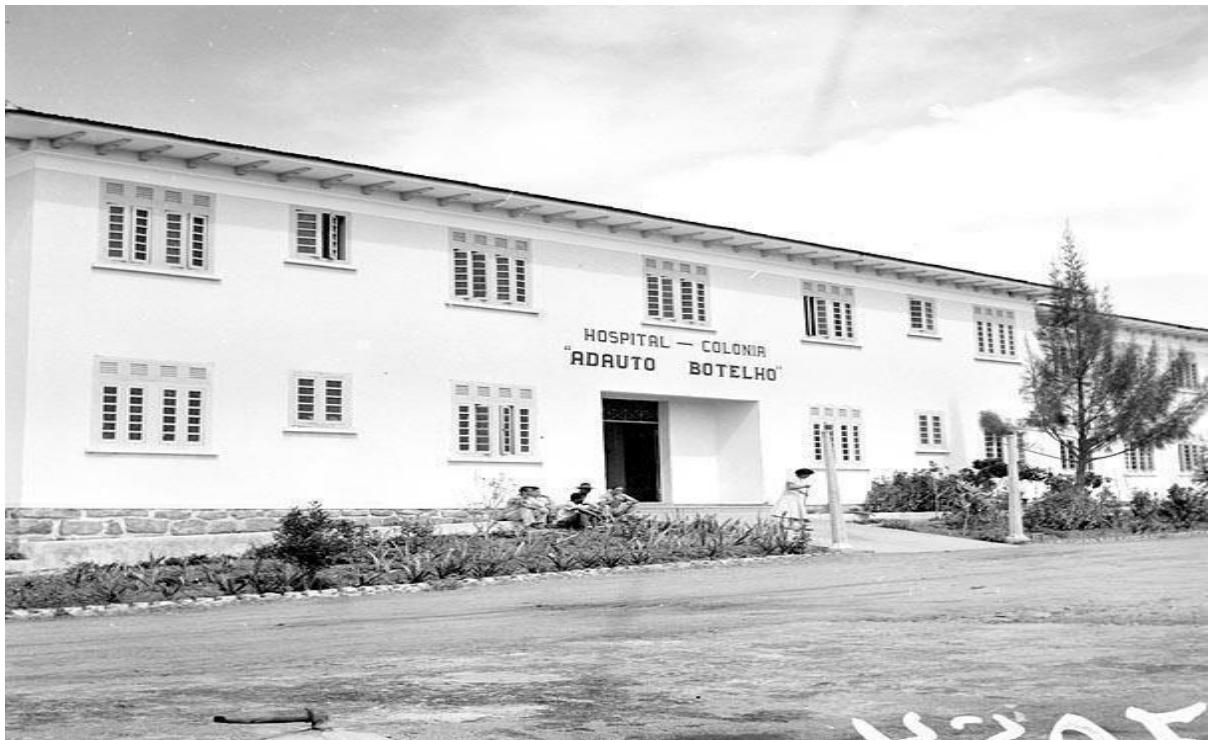
Imagem 20 — Fachada principal do Hospital Adauto Botelho em 1954
