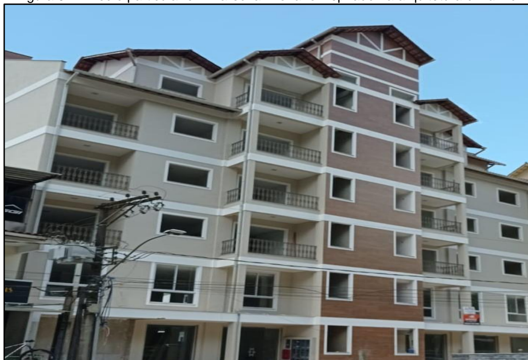
Figura 62 - Prédio particular em Marechal Floriano inspirado na arquitetura enxaimel
