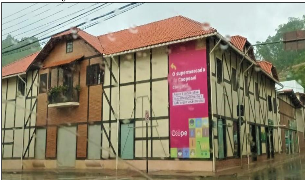
Figura 61 - Prédio comercial em Santa Maria do Jetibá-ES
