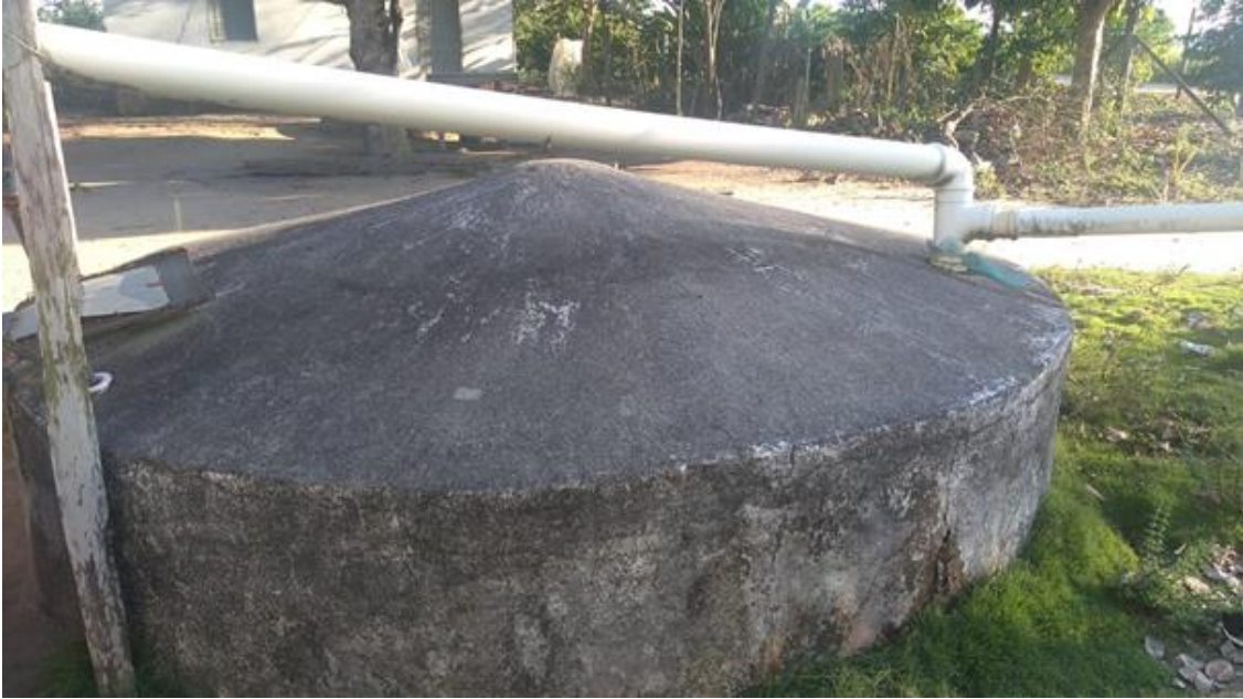
Fotografia 3 – Cisterna Seca construída na Comunidade Nova Vista
