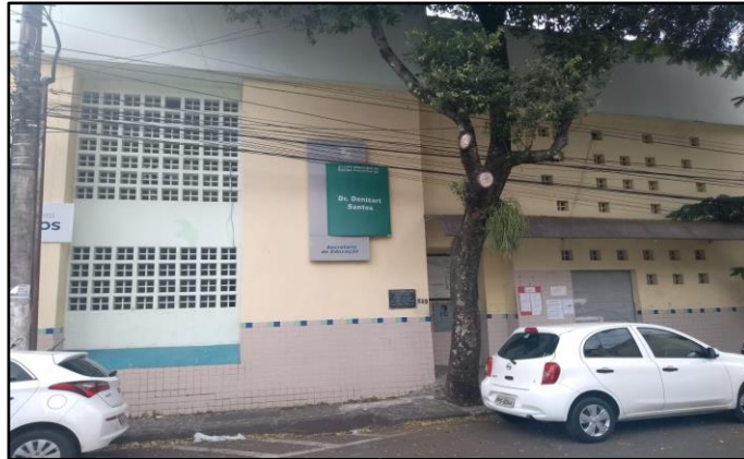
Imagem 1 – Fachada principal do CMEI
