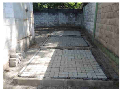
Colocação dos blocos de revestimento e obra finalizada.
