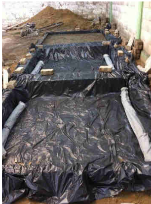
Colocação de manta impermeável e drenos.
