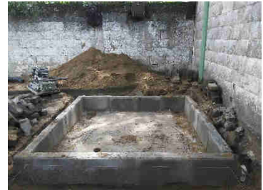
Delimitação com guias de concreto de cada módulo.
