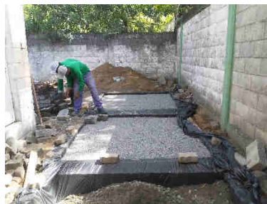
Coloção de base permeável e camafa de assentamento.
