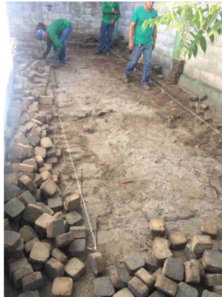
Retirada do pavimento existente e locação dos módulos.
