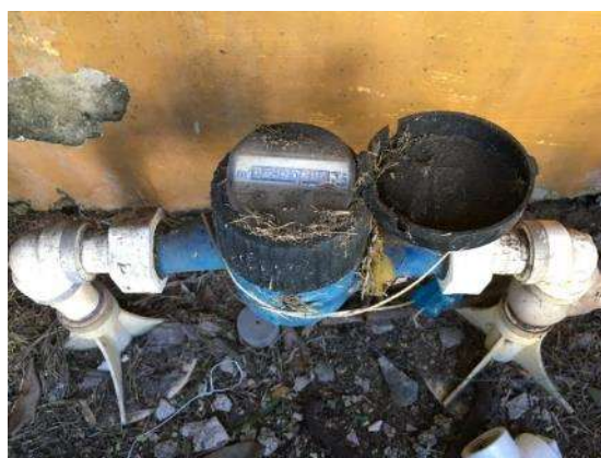
Figura 14- Hidrômetro - UBS Jardim Camburi
