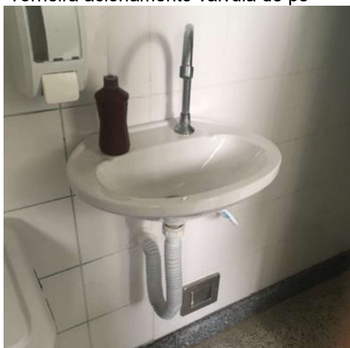
(f) - Torneira acionamento válvula de pé
