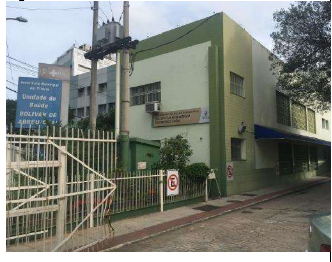
Figura 11 - UBS Forte São João
