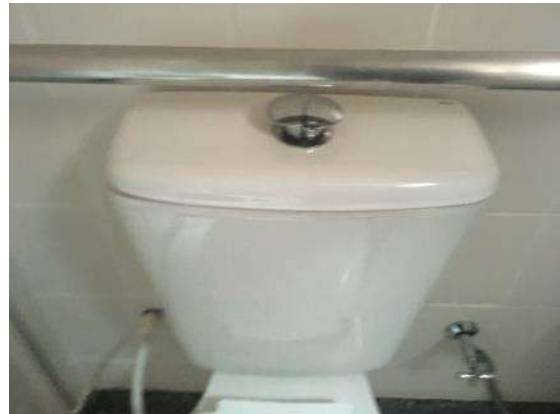
Figura 26 - Bacia com caixa acoplada UBS Bonfim
